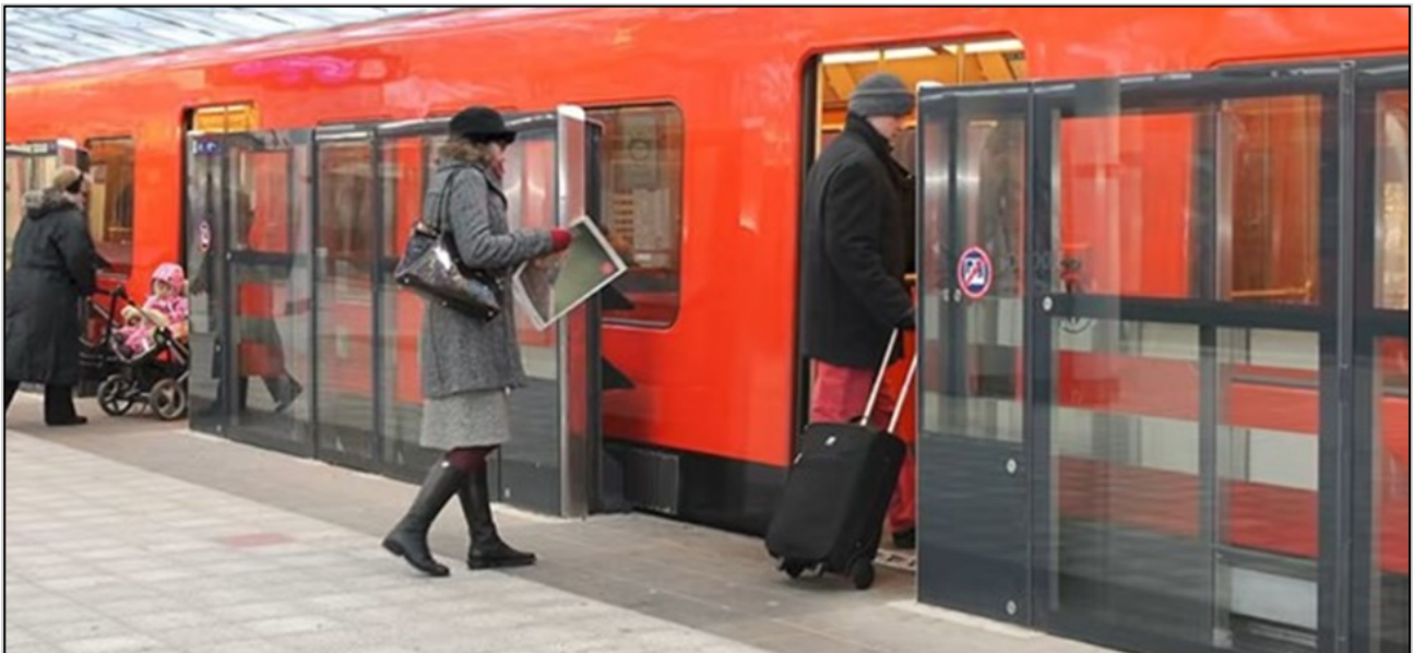
Kuva 1. Vuosaaren metrolaiturin ovet vuonna 2015. (Kuva: Pääkaupunkiseudun Kaupunkiliikenne Oy)
