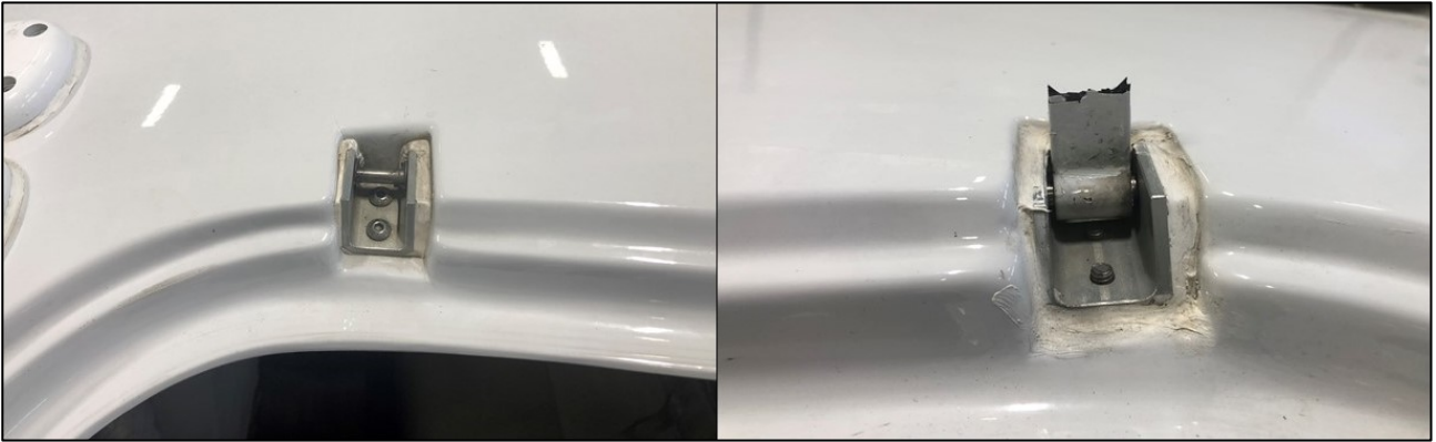
Kuva 2. Kuvakollaasi rikkoontuneista oven saranoiden kiinnityskohdista. (Kuvat: OTKES)
