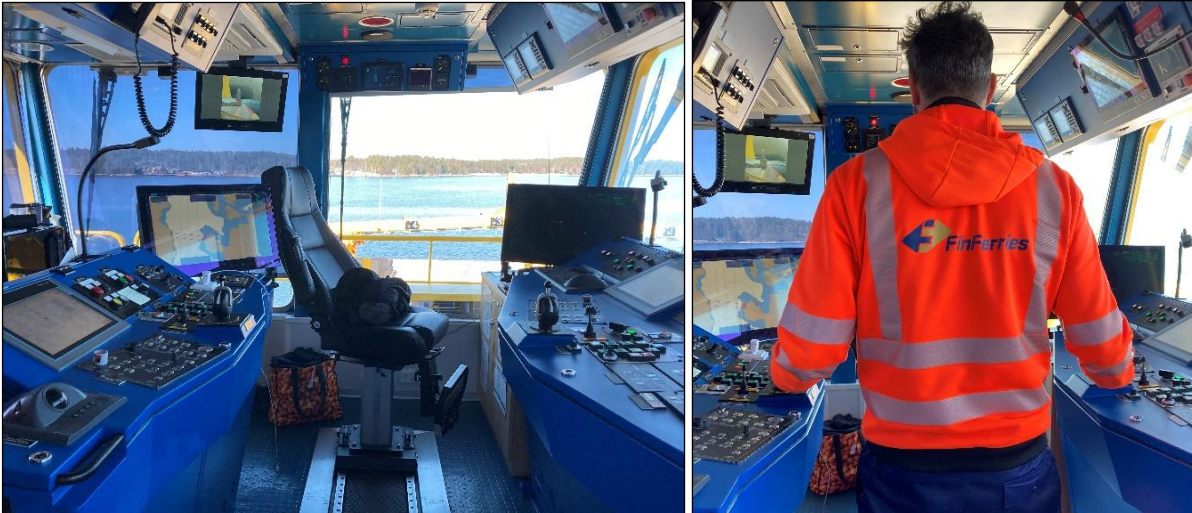
Bild 13. På den vänstra bilden en vy från styrhytten på vajerfärjan L-317, från manövreringsplatsen i riktning mot fören. På bilden syns manövreringsreglagen vid kanten av konsolerna, på båda sidorna om manövreringsplatsen. På den högra bilden ser man hur färjan manövreras med användning av båda manövreringsreglagen samtidigt. (Bilder: OTKES)
