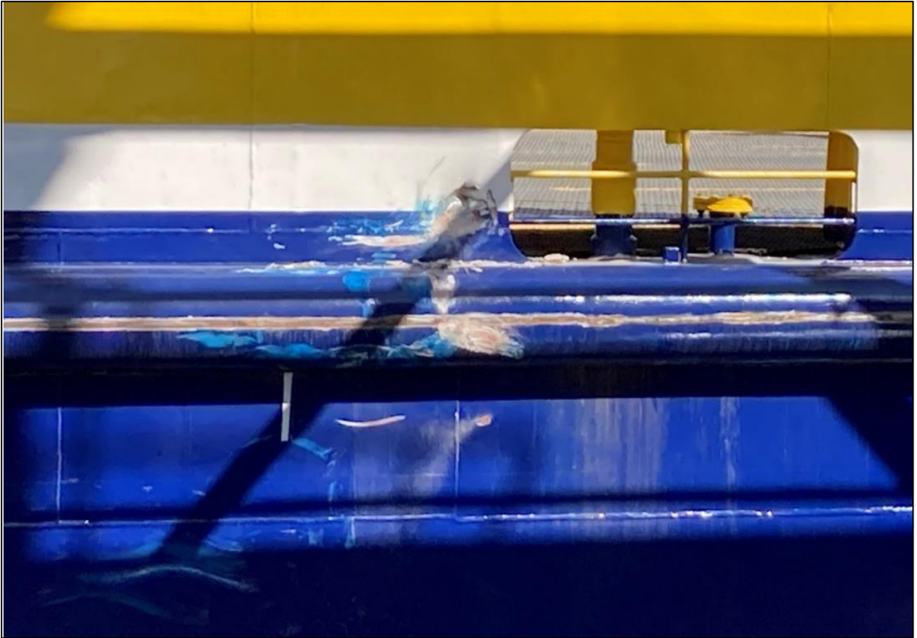
Bild 2. Kollisionerna med bryggklaffen och båthamnens brygga orsakade intryckningar i och lackskador på färjans skrov. (Bild: OTKES)
