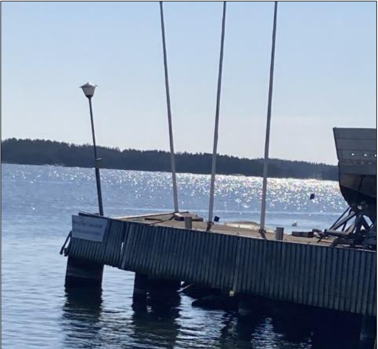
Kuva 3. Lossin törmäys väänsi venesataman laiturirakenteita. (Kuva: OTKES)
