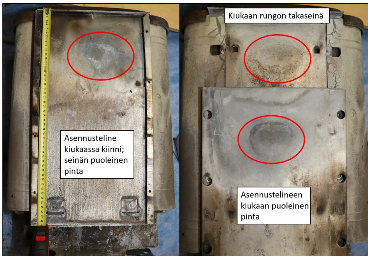
Kuva 14. Kiukaan ja asennustelineen yläosassa keskellä oli havaittavissa lämpöjälkiä. Vasemmalla on asennustelineen seinän puoleinen pinta sekä oikealla alhaalla asennustelineen kiukaan puoleinen pinta ja ylhäällä kiukaan rungon takaseinä. (Kuva: OTKES)
