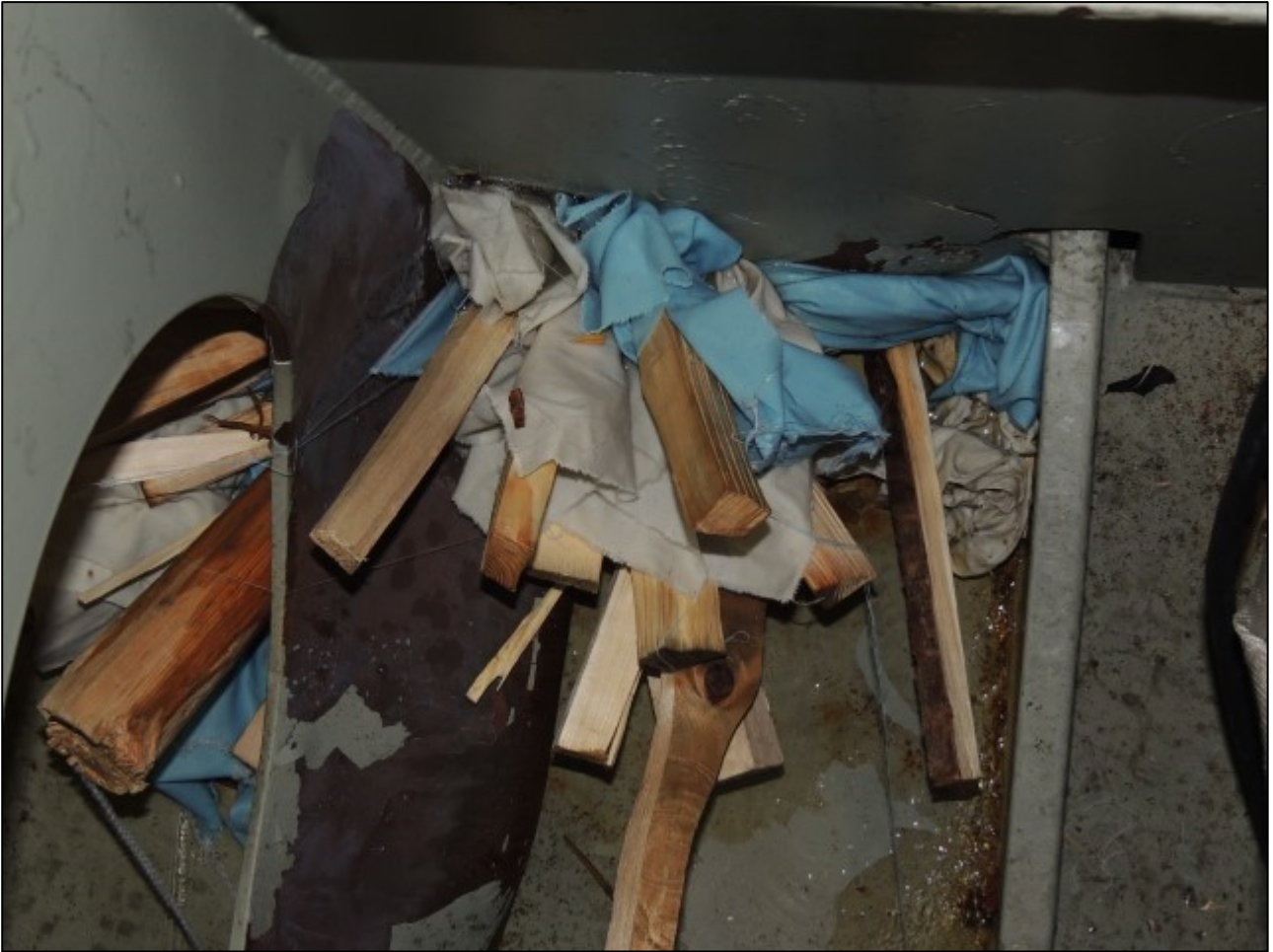
Kuva 6. Vuotokohta tukittuna ja kiilattuna keulapotkuritilassa vauriontorjunnan jälkeen. (Kuva: Onnettomuustutkintakeskus)
