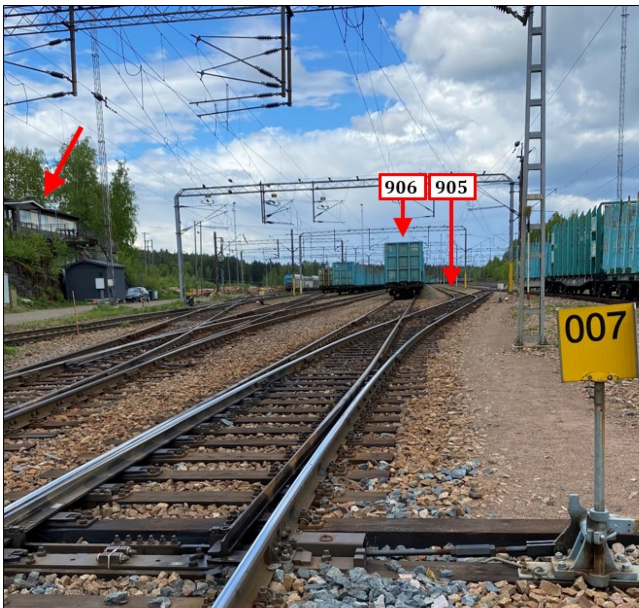
Bild 3. Bild av växeln V007 från tågets ankomstriktning. På bilden är växeln i en position som leder till spår 905 (mot höger). I olycksituationen ledde växeln till spår 906 (rakt fram), där vagnarna stod. Vid bildens vänstra kant syns Kuusankoski station (pil), där bangårdstrafikledarna arbetar. (Bild: OTKES)
