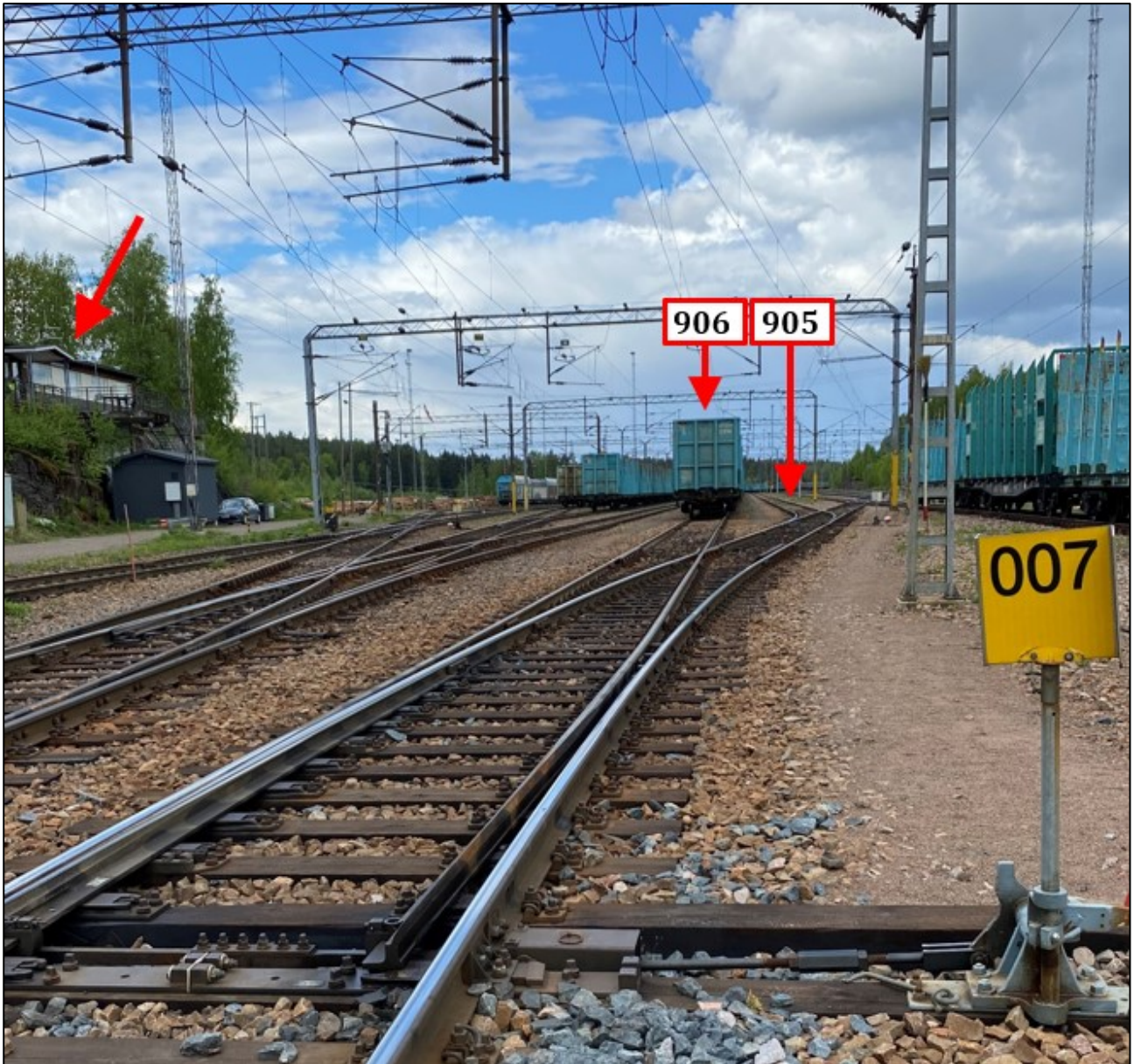
Kuva 3. Kuva junan tulosuunnasta vaihteesta V007, joka kuvassa on raiteen 905 suuntaan (oikealle) johtavassa asennossa. Onnettomuustilanteessa vaihte johti raiteelle 906 (suoraan) jolla vaunut olivat. Kuvan vasemmassa laidassa näkyy Kuusankosken asema (nuoli), jossa ratapihaliikenteenohjaajat työskentelevät. (Kuva: OTKES)
