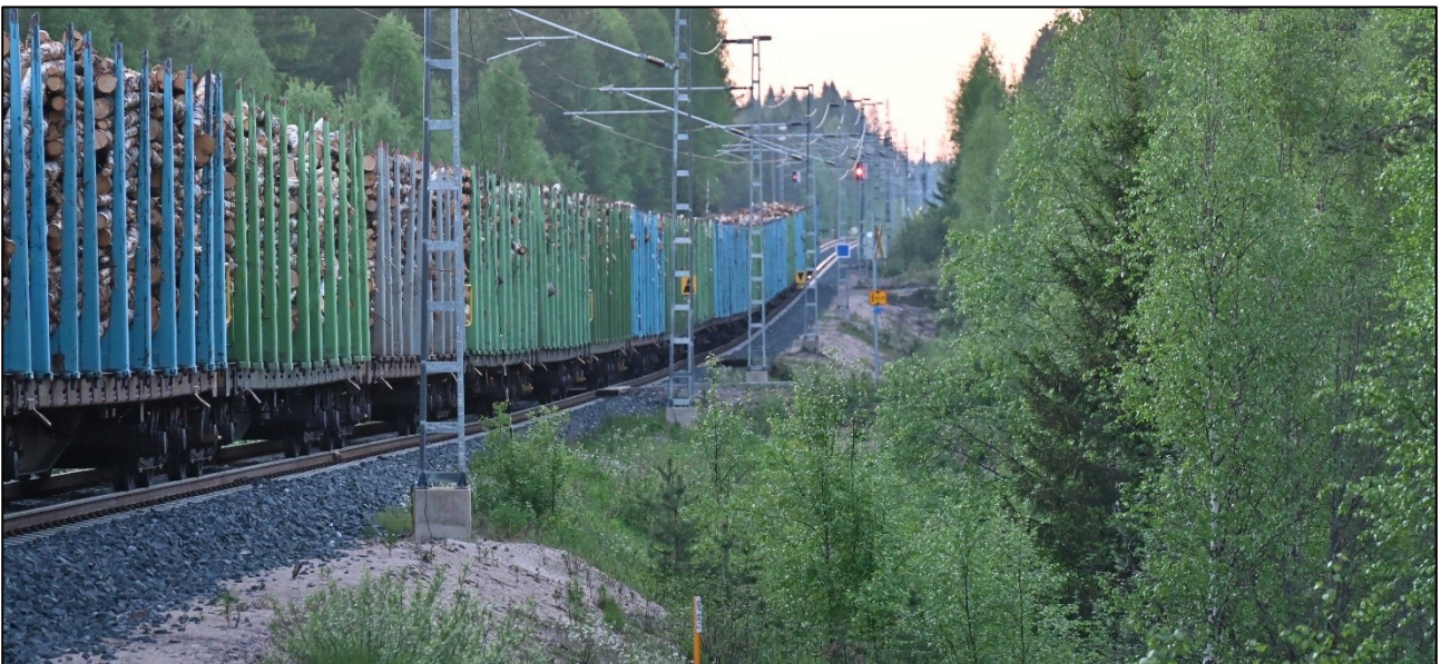
Kuva 3. Näkemä 8 metriä ennen kiskoja junan tulosuuntaan. (Kuva: OTKES)
