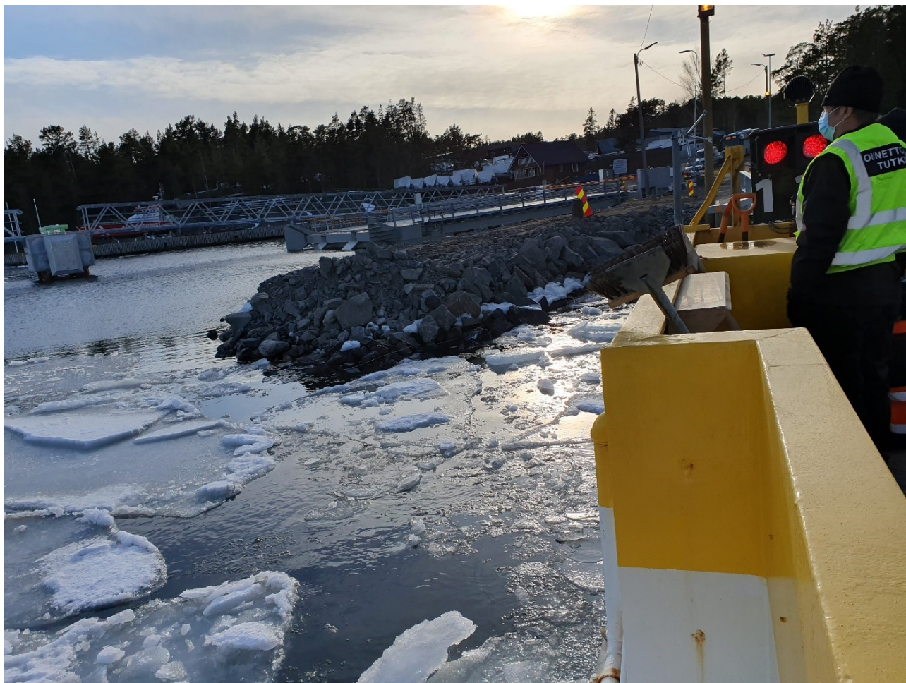
Bild 1. Under konstruktion varande vågbrytare, som PROSTVIK 1 kolliderade med (bild: OTKES)
