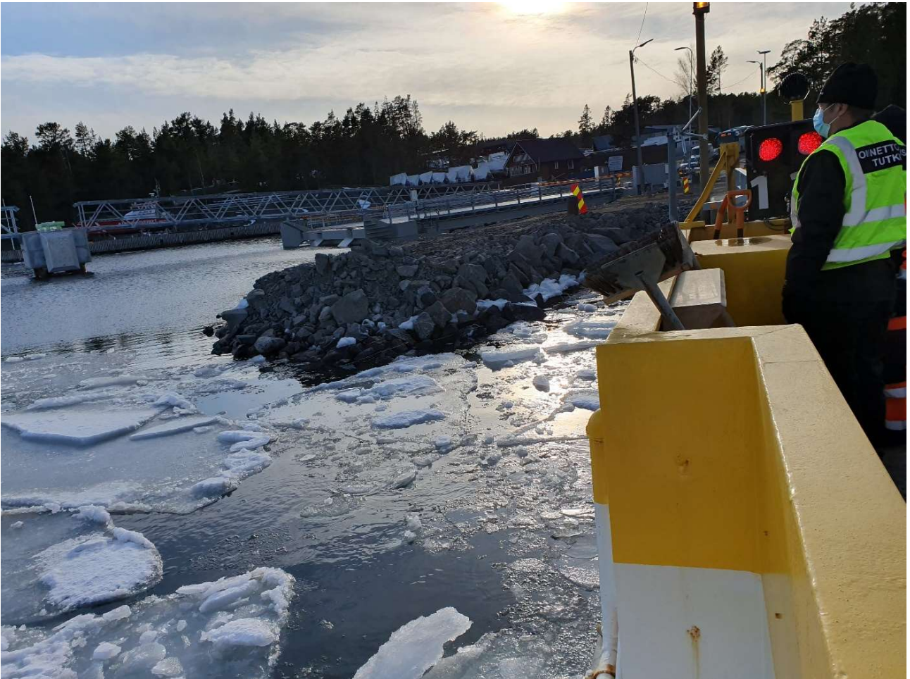
Kuva 1. Rakenteilla oleva aallonmurtaja, jonka vedenalaisen pengerrykseen PROSTVIK 1 törmäsi. (kuva: OTKES)
