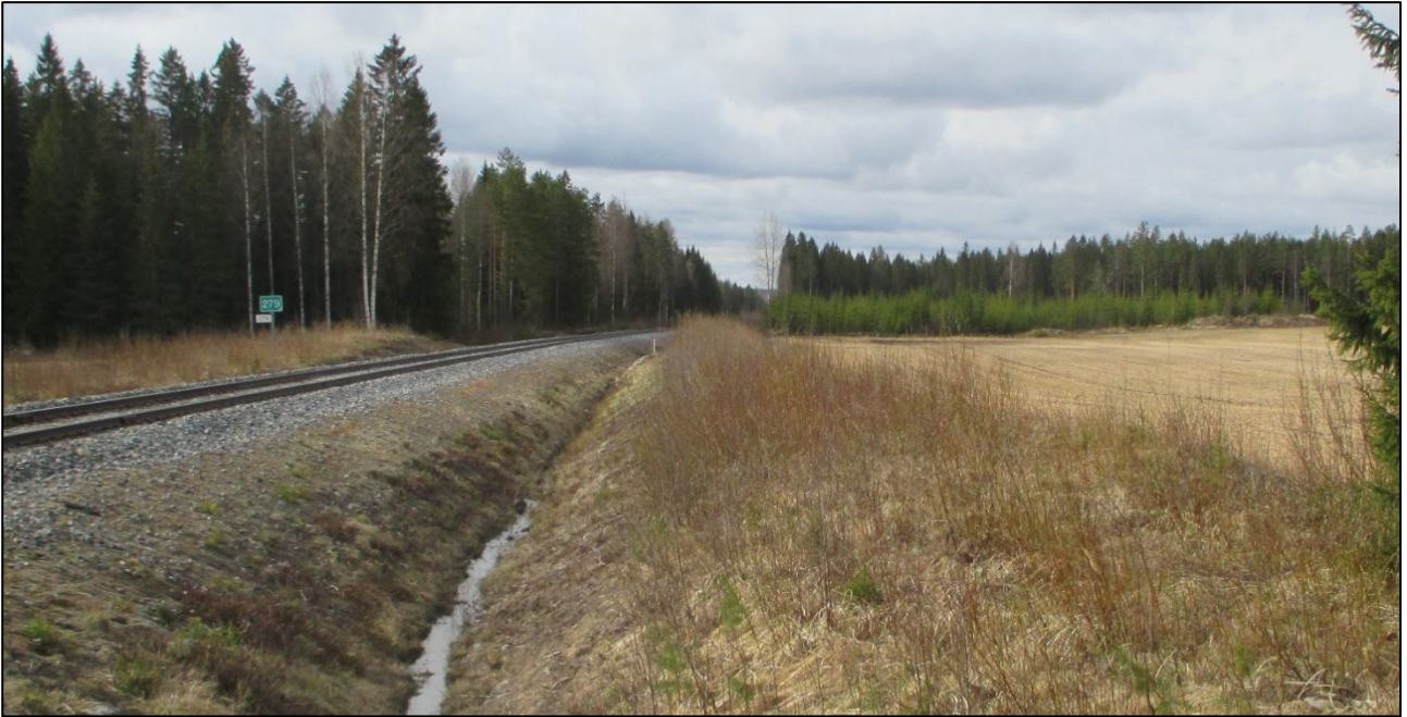
Kuva 5. Kuva traktorin tulosuunnasta junan tulosuuntaan 8 m ennen tasoristeystä. Traktorista noin 3 m:n korkeudelta katsottaessa kuvassa oleva pajukko aiheuttaa vähemmän katvetta. (Kuva: OTKES)
