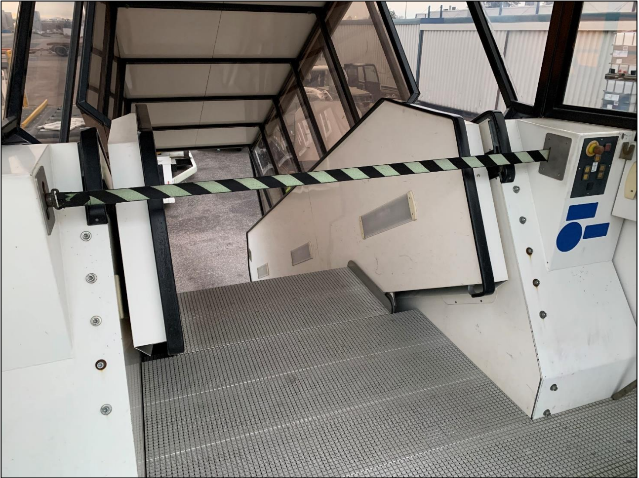
Bild 3. Trappbilens övre plattform och säkerhetslina. Vid säkerhetslinans högra ände finns den övre plattformens manöverpanel och nödstoppsknappen. (Bild: OTKES)
