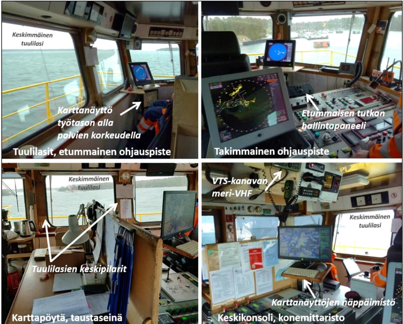
Kuva 7. Merguksen ohjaamo on sokkeloinen ja epäergonominen. Etummaisesta ohjauspisteestä tutkanäyttö erottuu sinisenä molemmissa yläkuvissa. Alemmissä kuvissa näkyy ohjaamon keskiosaa hallitseva karttapöytä ja mittaristojen muodostama kokonaisuus. (Kuva: OTKES)
