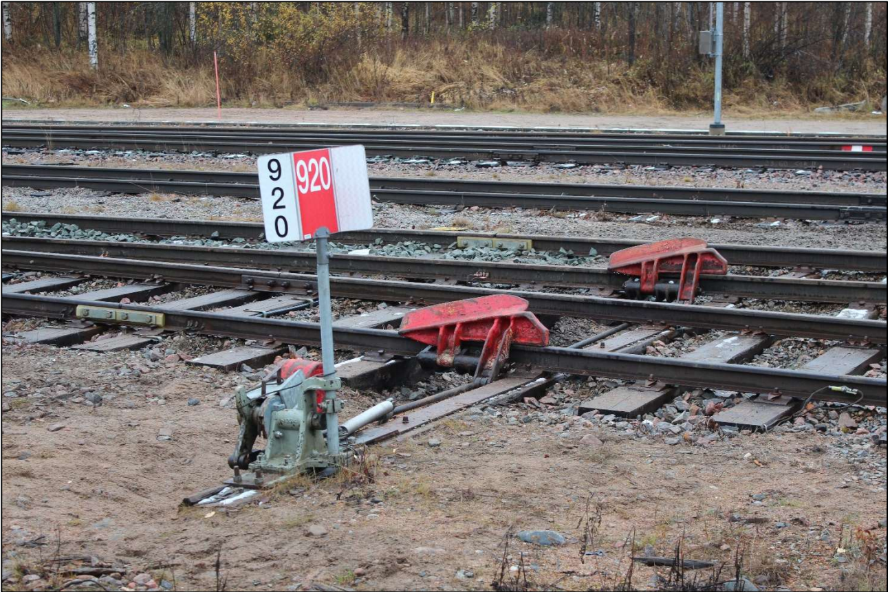
Kuva 5. Raiteensulut käännettynä kiskolle korjauksen jälkeen. (Kuva: OTKES)
