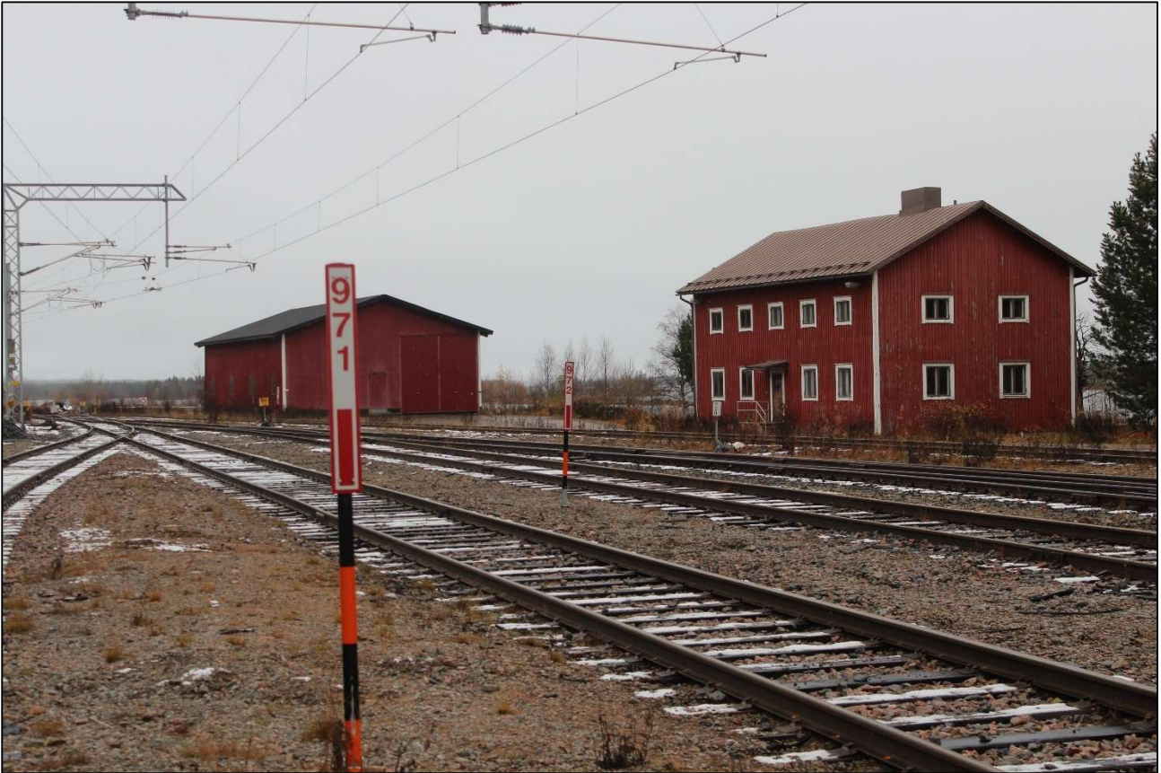
Kuva 6. Junakulkutien päätekohtamerkit. Merkit osoittavat raiteen numeroinnin vain yhteen suuntaan. (Kuva: OTKES)
