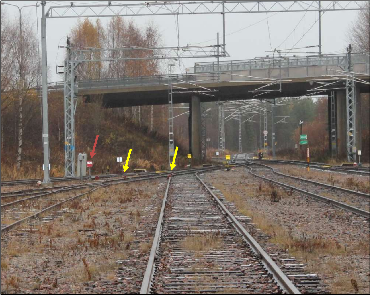
Kuva 7. Näkymä veturin tulosuunnasta raiteella 973. Raiteensulut (keltaiset nuolet) ja raiteensuluista kertova merkki (punainen nuoli). (Kuva: OTKES)
