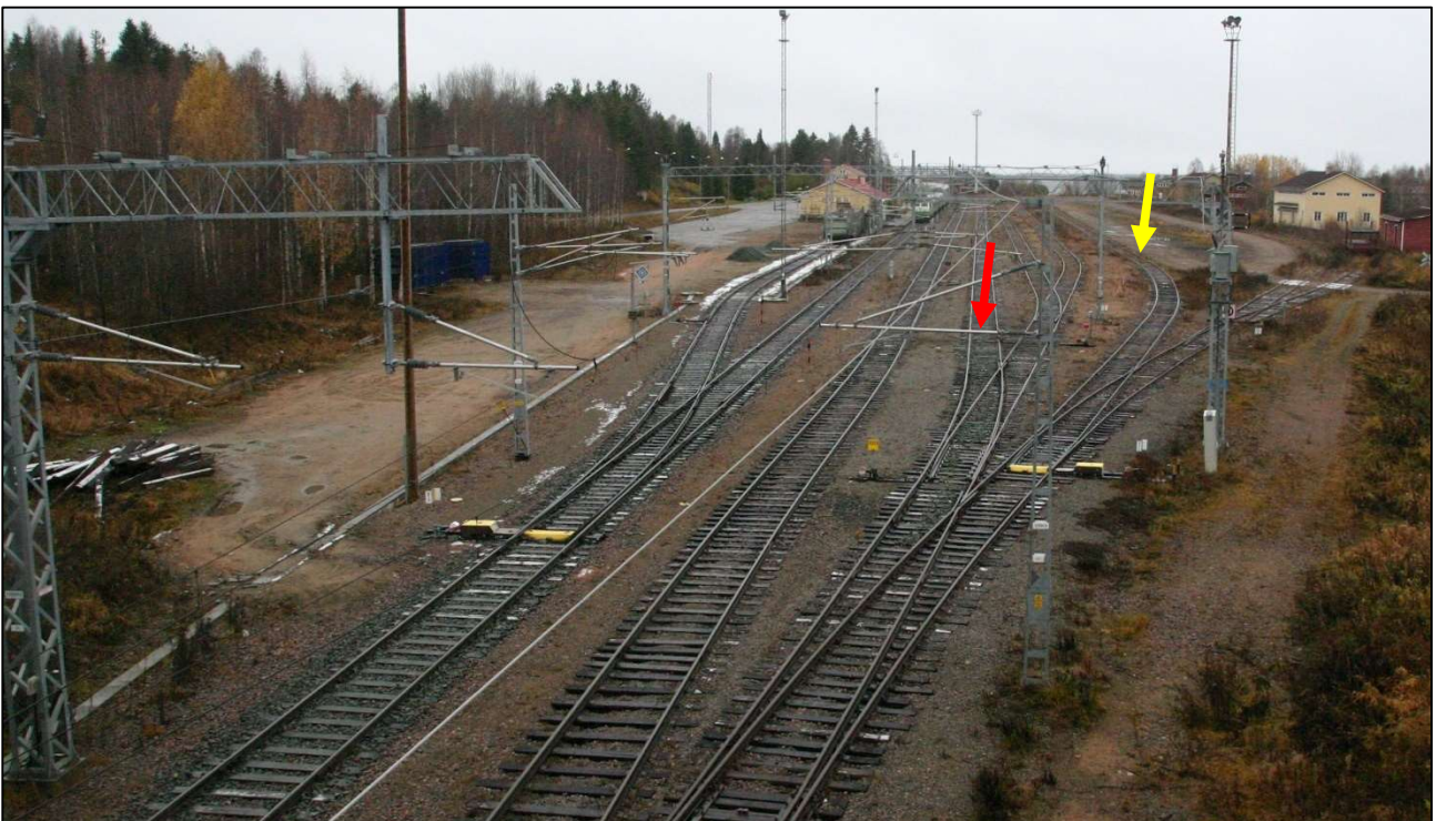
Kuva 3. Ratapiha etelän (Rovaniemen ja Patokankaan) suunnasta. Raide 973 ja törmäyskohta (punainen nuoli). Raide 976 (keltainen nuoli). (Kuva: OTKES)
