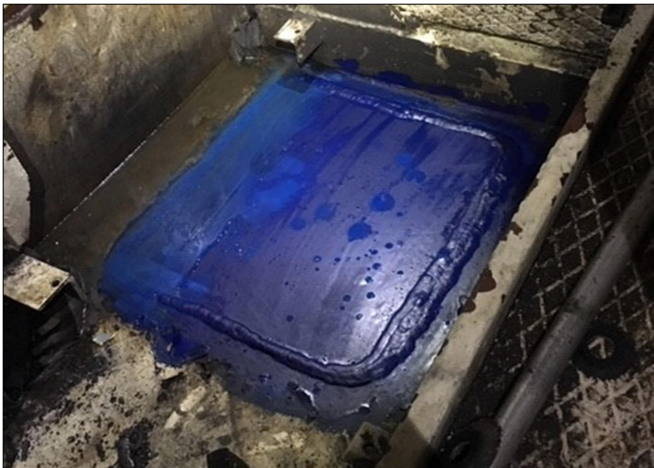
Bild 8. Den reparationsskiva som monterats på varvet. (Bild: Transport- och kommunikationsverket)
