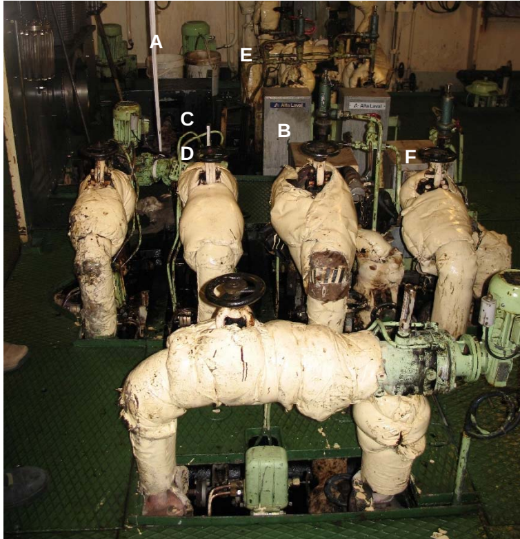
Bild 6b. Överblick av underhållsarbetets område, 16.12.2013. Hjälpmaskinernas värmeväxlare syns längre bak.
