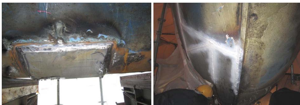
Bild 30. Till vänster – temporär reparation vid kölen med pålagda plåtar. Till höger – nya bottenplåtar på bulben. Bilder: klassificeringssällskapet DNV GL.
