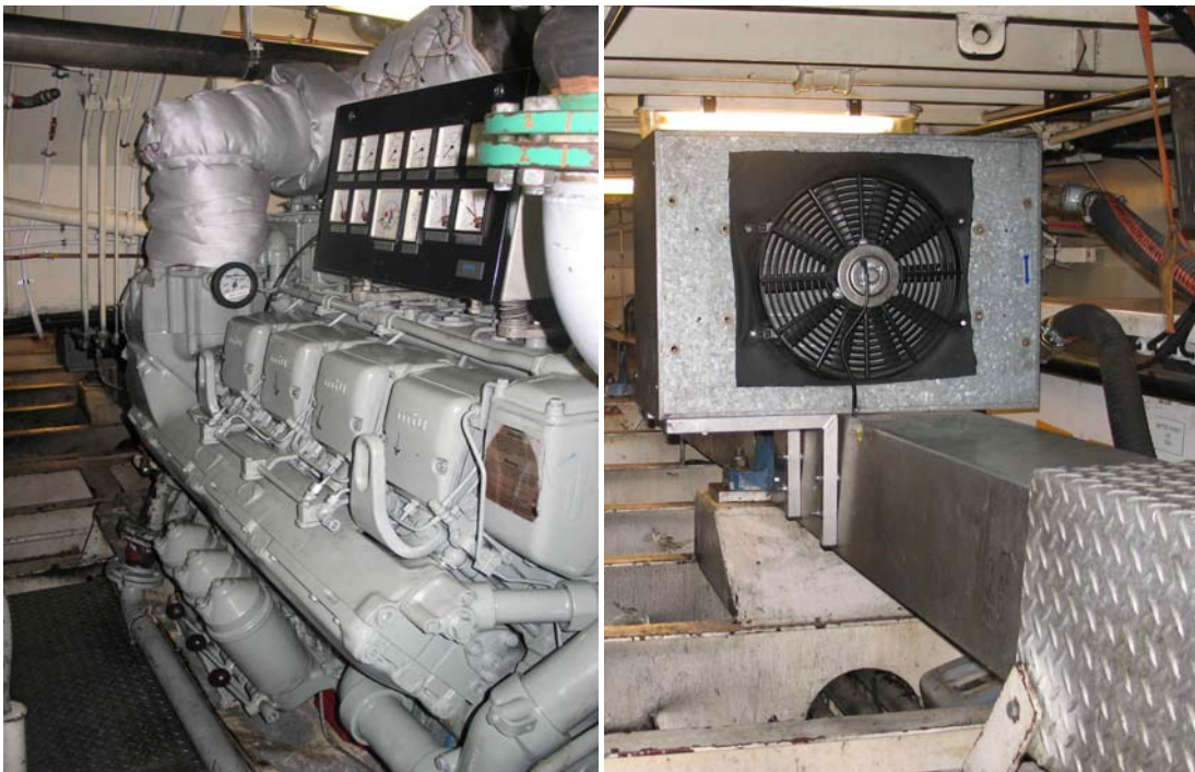
Bild 4a. Till vänster huvudmaskinen från SB-sidan, axeltunneln i bakgrunden. Till höger fläkten för att förbättra huvudmaskinens kylning. Fläkten ligger i axeltunneln. Foto taget 31.5.2013.
