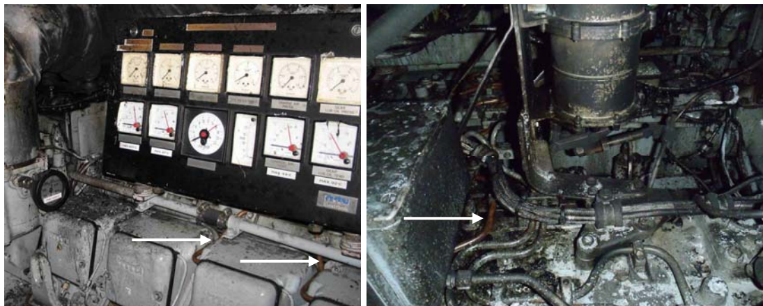
Bild 15. I bilderna syns kopparfärgade och nedsmutsade bränsleinsprutningsrör. En del av rören visas med pilar.
