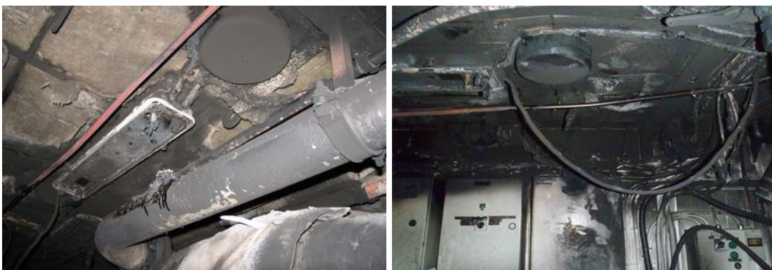
Bild 12. Brandskador i taket av maskinrummet.
