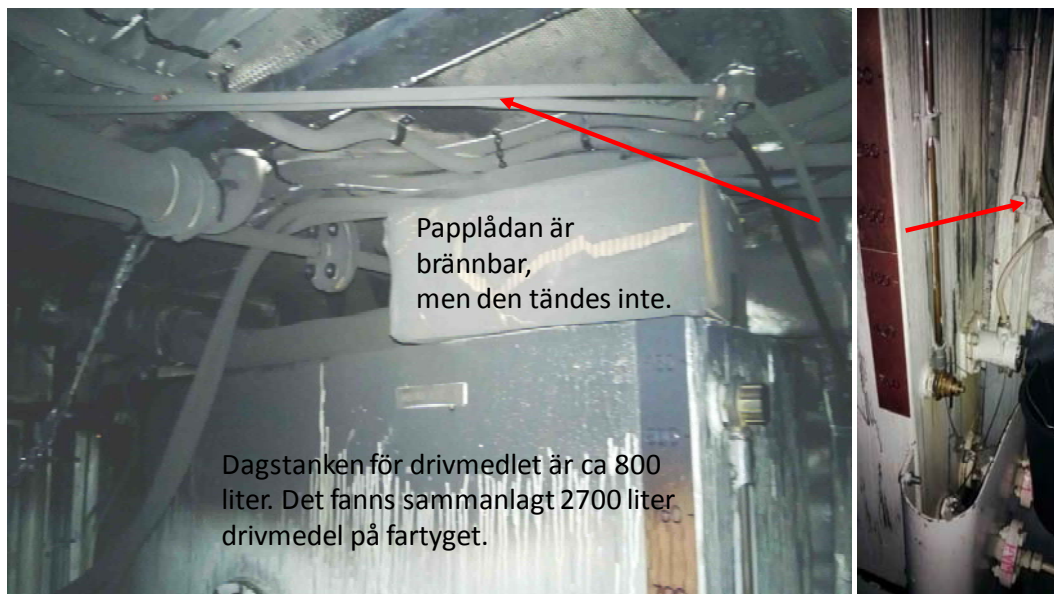
Bild 10. Bilden visar dragningen av snabbstängningsvajer för bränsleventilerna vid drivmedelstanken. Bilden till höger visar vajrarnas fastsättning i ventiler. Pilarna pekar på skyddsroren.
