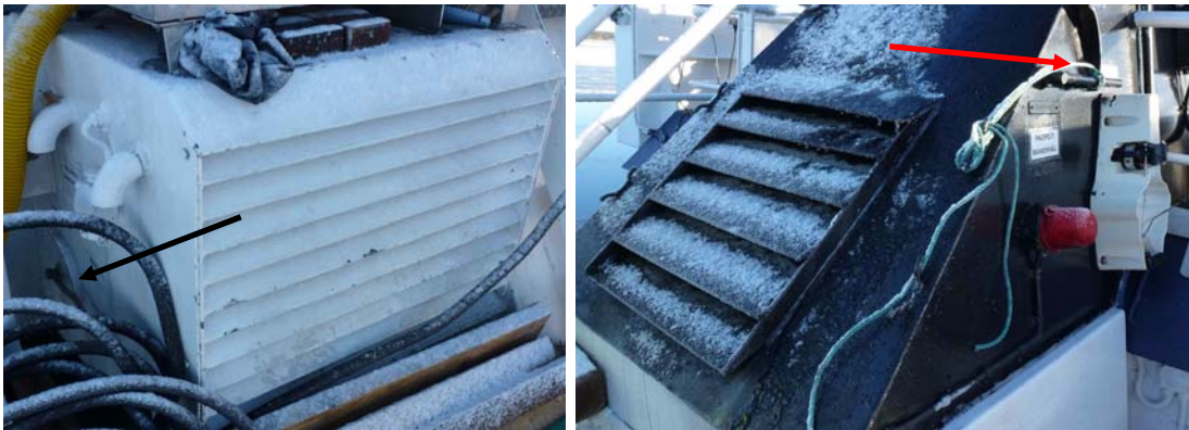
Bild 9. Brandspjällen för maskinrummets luftintag (till vänster) och avluftskanalen (till höger), båda utmärkta med pilar. Se också bild 1. Foto 1.2.2013.
