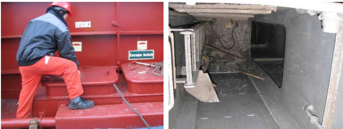
Kuva 4. Vasemmalla lastiruuman miesluukku. Oikealla ruumaan johtavat tikkaat ja välitasanne, kuvaussuunta keulaan päin.
