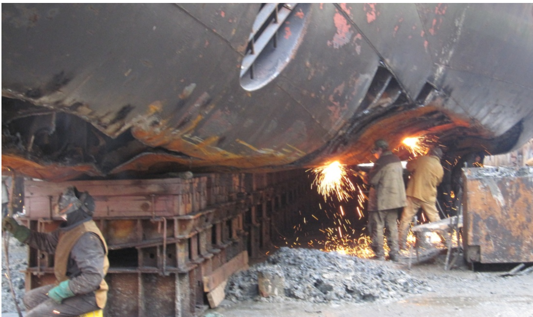
Kuva 8. Vaurioita aluksen keulan vasemmalla puolella.
