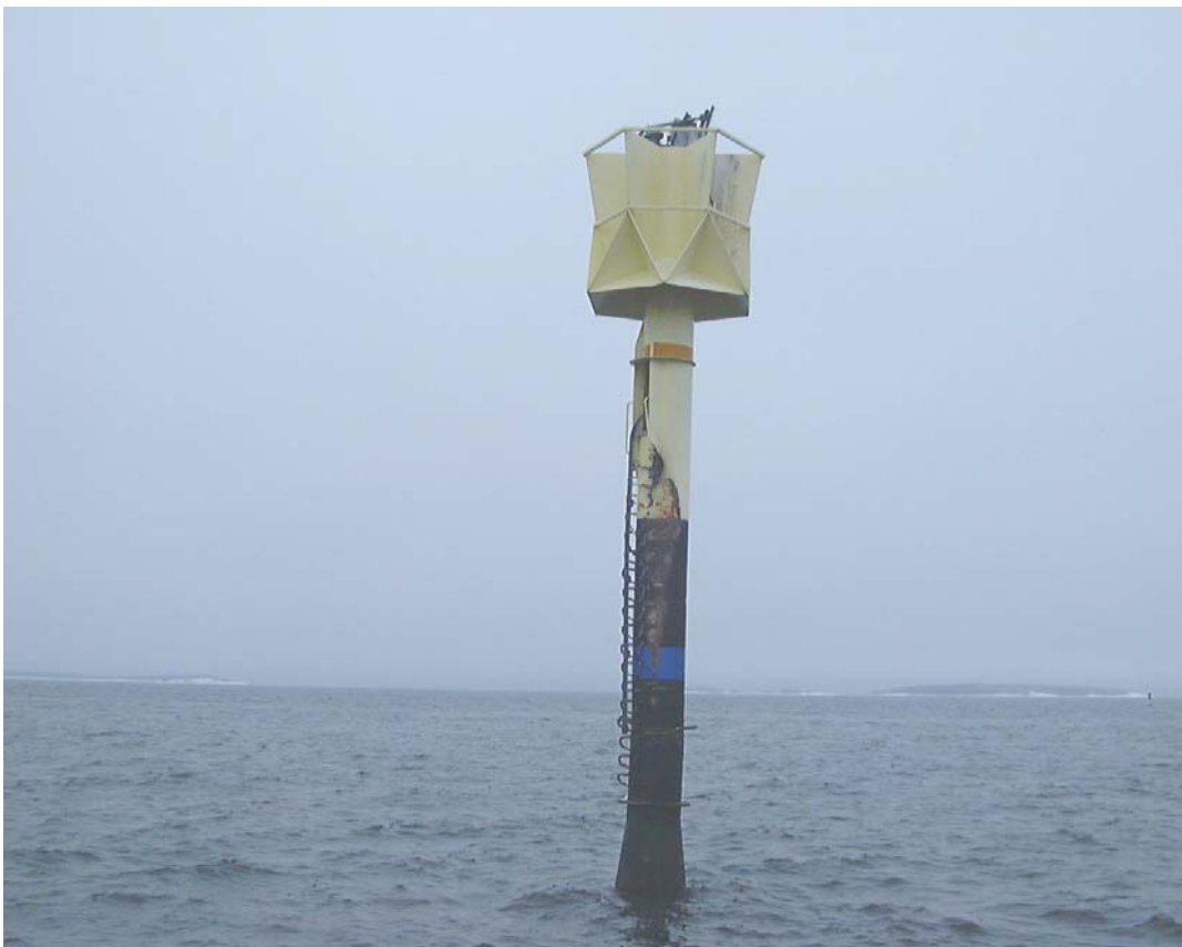
Picture 9. Damaged edge mark Lålätan.
