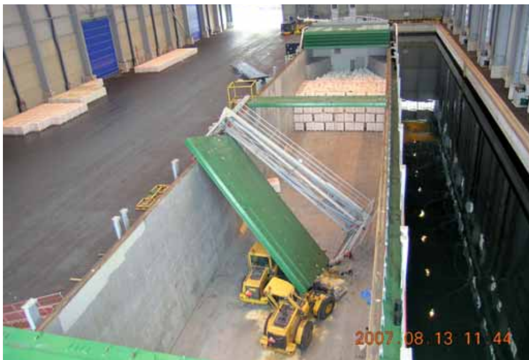
Kuva 2. Kansiluukku ja vaurioitunut kauhakuormaaja lastiruumassa.
