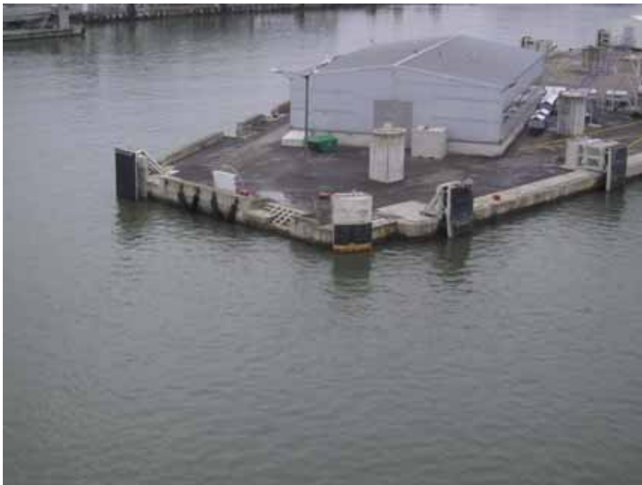
Bild B4b. I kajhörnet finns det en fendert mot vilken fartyget kan stötta sig då fartyget vänds i riktning mot kajen.
