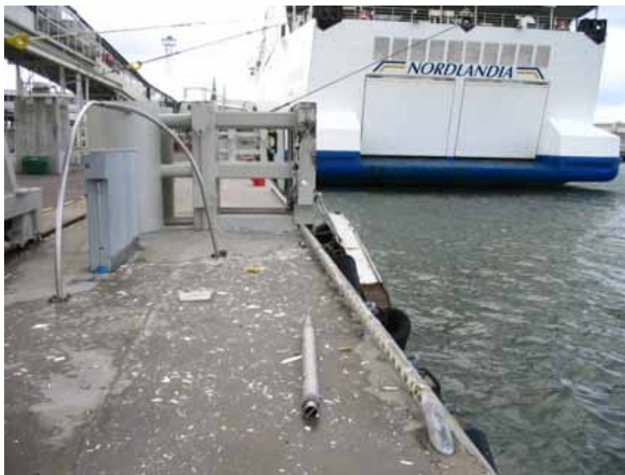
Bild 21. Kajens skadade fendert.
