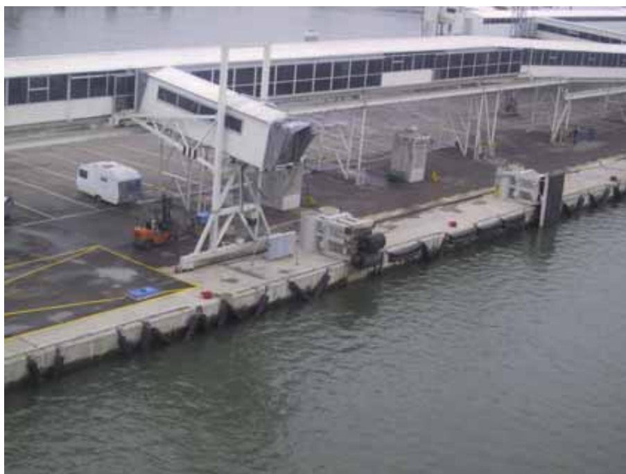
Bild 22. I förgrunden kajens passagerarlandgång och fendert, som båda tog skada av NORDLANDIAS kollision. I bilden har den skadade fenderten till vänster reparerats temporärt och till höger syns en hel fendert.
