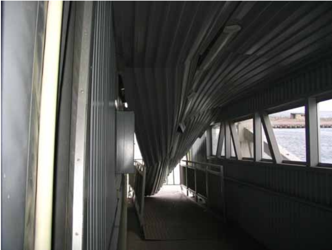
Bild 23. Skadorna på passagerarlandgången.
