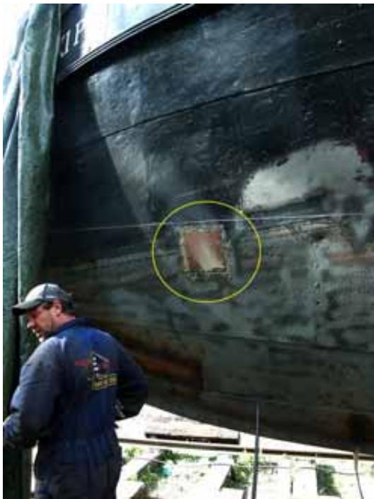
Kuva 14. Käymälän runkoläpiviennin kohta laidoituksessa umpeen hitsaamisen jälkeen.
