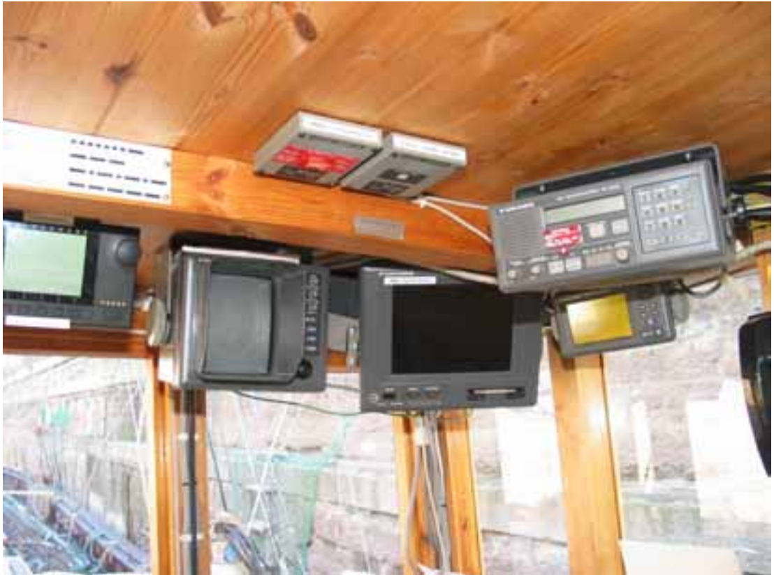
Kuva 3. Komentosillan katon oikea puoli. Äärimmäisenä vasemmalla on kaikuluoti ja sen oikealla puolella on tutka ja oikealla on GPS. Lähimpänä GPS:n edessä on VHF radiopuhelin.
