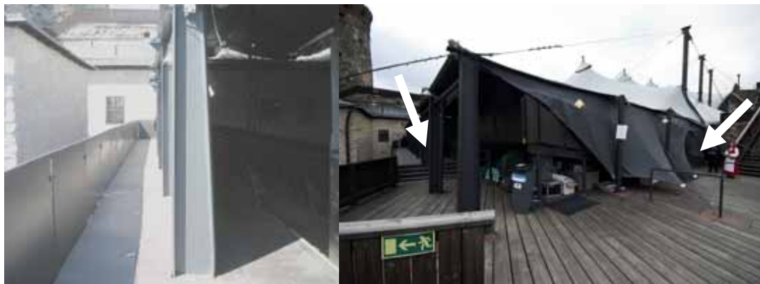
Kuva 42. Oikeanpuoleisessa kuvassa ylätasanteen kautta kulkevan kulkureitin alkukohta [3]. Kuvassa näkyvät sekä vasemmalla olevat kaksi kulkureittiä katsomosta (f) (vasen nuoli) että kulkureitin [2] ulkoaukko (oikea nuoli) (vrt. kuva 37). Vasemmanpuoleisessa kuvassa näkyy yksityiskohtana kulkureitit A-katsomon takaa ulos (f) (leveydet: takaseinän ulkopuolinen kulkukäytävä 80 cm ja kulkuaukko katsomon oikeassa takanurkassa 125 cm).
