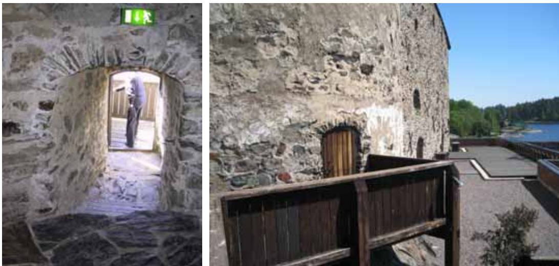
Kuva 49a. Vasemmassa kuvassa on käytävä Kellotornista (p) ylätasanteelle ja oikeassa kuvassa sama ovi kuvattuna ulkoapäin (i). Tästä kulkureitti jatkuu portaiden (i)-(j) kautta (kuva 45) pääportille (d) (kuva 41).
