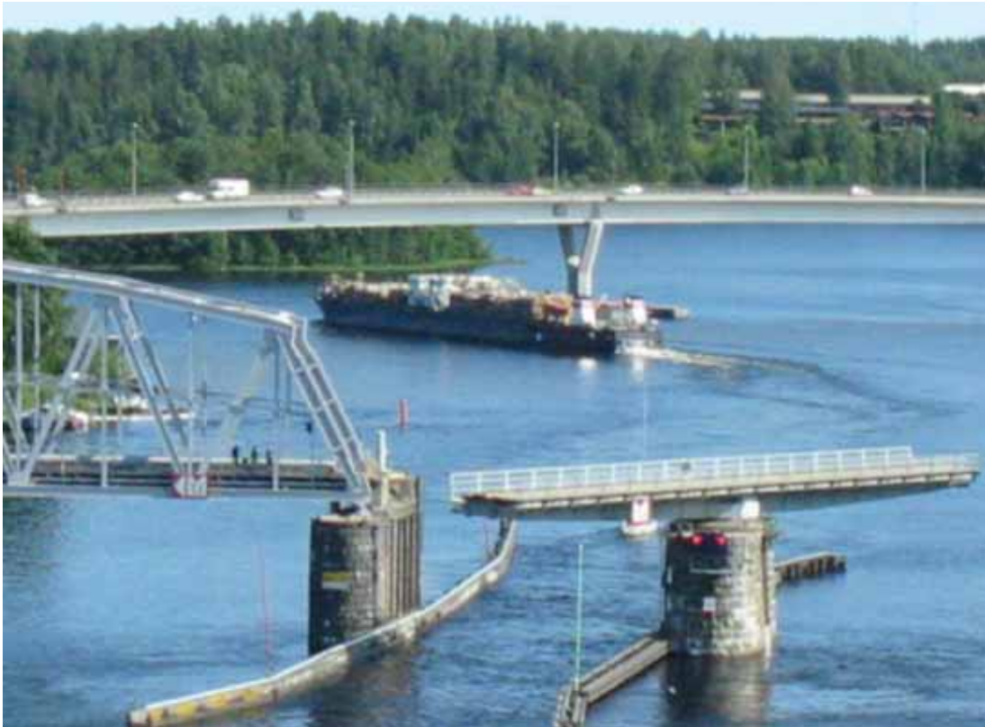
Kuva 21. KRASNOVIDOVO ohittamassa maantiesiltaa (klo 10:50:06). (© Timo Härkönen)
