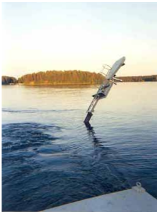
Kuva 19. Vaurioitunut merimerkki, joka toimi myös ponttonisillan pään tukipisteenä.
