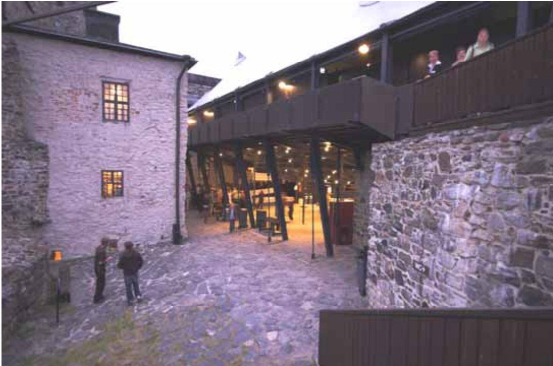
Kuva 33 Katsomorakenteen takaosa. Kuvassa näkyy katsomon alla oleva lämпиö, jossa on yksi anniskeluravintoloista. Etualalla vasemmalla on Isoa linnanpihaa, minne on sijoitettu tupakointialue. Oikealla alhaalla näkyy muurille johtavien portaiden puinen kaide (vrt. kuva 36).
