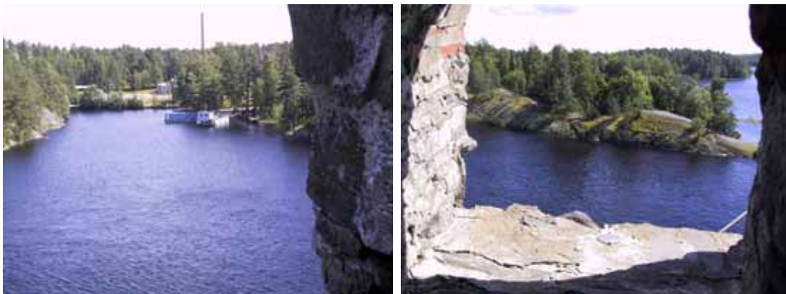
Kuva 56. Mallatsaareen lauttaa varten rakennettu lastaus- ja purkamispaikka (vasemmalla). Mallatsaaren lähin ranta ei ole sovelias aluskuljetuksille (oikealla).
