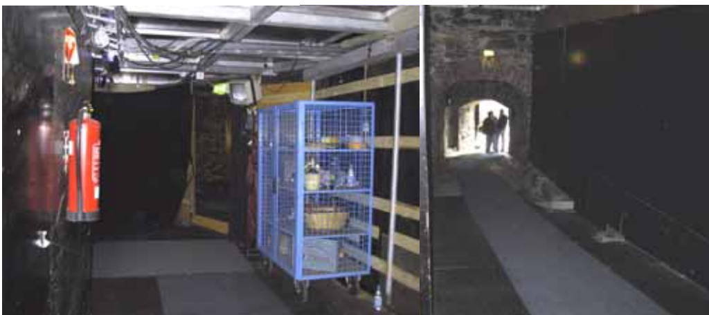
Kuva 51. Vasemmassa kuvassa on näyttämön alla oleva käytävä, johon kuvaan 50 merkityt kulkuaukot johtavat. Tästä käytävästä johtaa Suvorovin linnanpihalle oikeassa kuvassa näkyvä käytävä (k), taustalla olevan aukon leveys on 200 cm (vrt. myös kuva 30).
