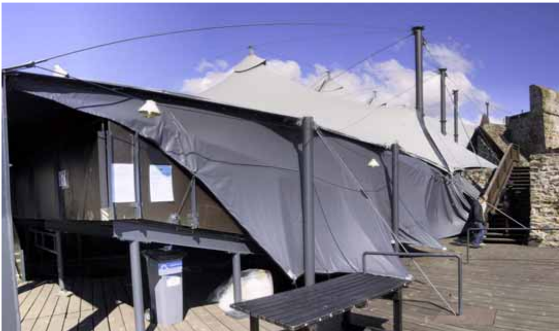
Kuva 34. Katon tiivis rakenne kuvattuna D-katsomon takanurkan ulkopuolelta. (Vertaa kuvaan 28 vuodelta 1975.)
