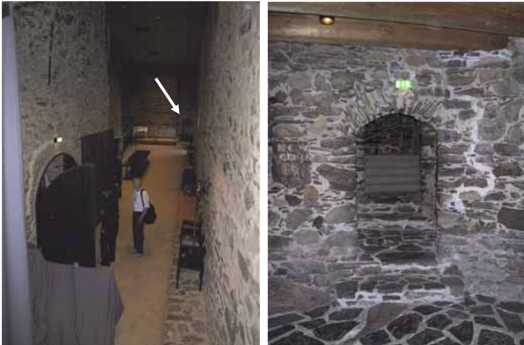
Kuva 47 Kongressisali [5] on vasemmassa kuvassa, kuvassa etualalla vasemmalla näkyy pariovi Isolta linnanpihalta ja takana oikealla nuolella merkitty ovi Kirkkotorniin (leveys 110 cm). Oikeassa kuvassa on kulkureitti Kirkkotornista eteenpäin Keskushalliin (n) => (o) (leveys 100 cm).
