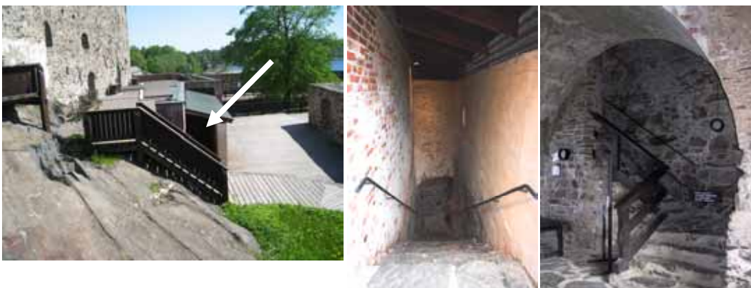
Kuva 45. Ylätasanteelta pääportille johtavaan holviin vievät portaat (i) => (j). Vasemmassa kuvassa keskellä on nuolella merkittynä portaisiin johtava aukko. Keskimmaisessä kuvassa ovat portaat (leveys 140 cm) ja oikeanpuoleisessa kuvassa portaiden alapää (vrt. kuva 46).
