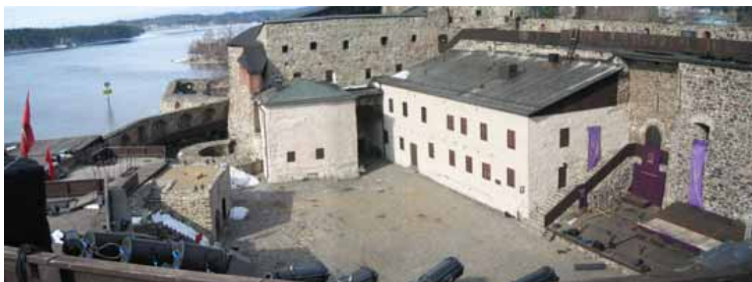
Kuva 29. Iso linnanpiha, johon joka vuosi rakennetaan kesän juhlien ajaksi katsomo, näyttämö ja kattorakenteet. Piha on pinta-alaltaan noin 1300 m 2 . Yhdistelmäkuva on otettu ylhäältä näyttämön suunnasta sen yläpuolelta. Taustalla vaaleiden rakennusten välissä on käytävä Isolta linnanpihalta Pienelle linnanpihalle. (Vrt. kuviin 28 ja 32 oopperajuhlien katsomosta.) Oikealla näkyvien portaiden yläpäässä oleva ovi johtaa Kongressisaliin.
