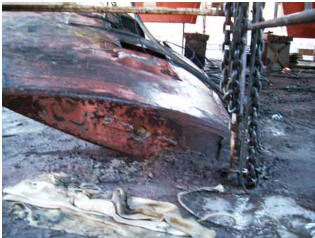
Bild 8. Skador på rodret.
