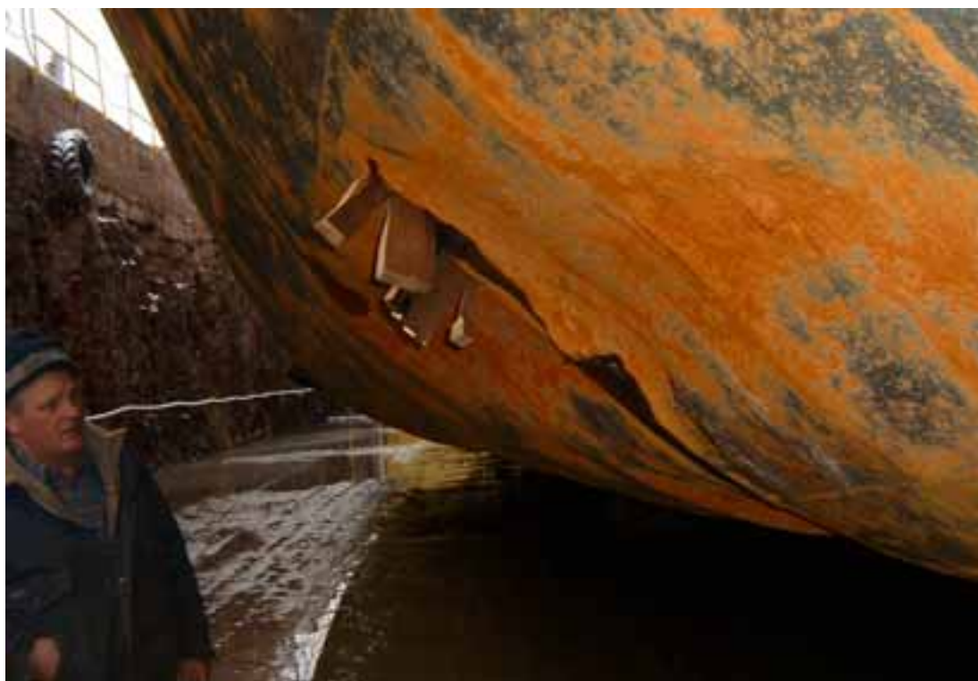
Bild 6. Revan vid maskinrummet.
