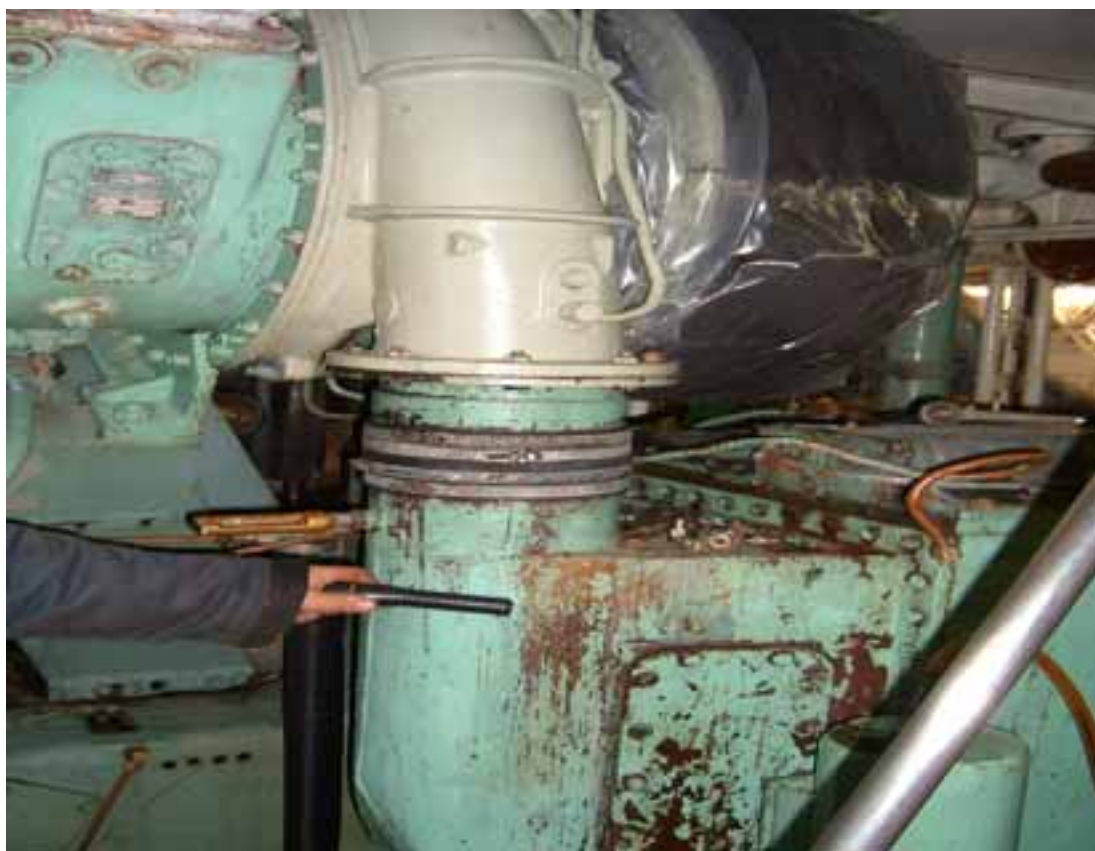
Bild 7. Till följd av läckorna som uppkom vid grundstötningen steg vattnet i maskinrummet upp till det ställe som visas på bilden.
