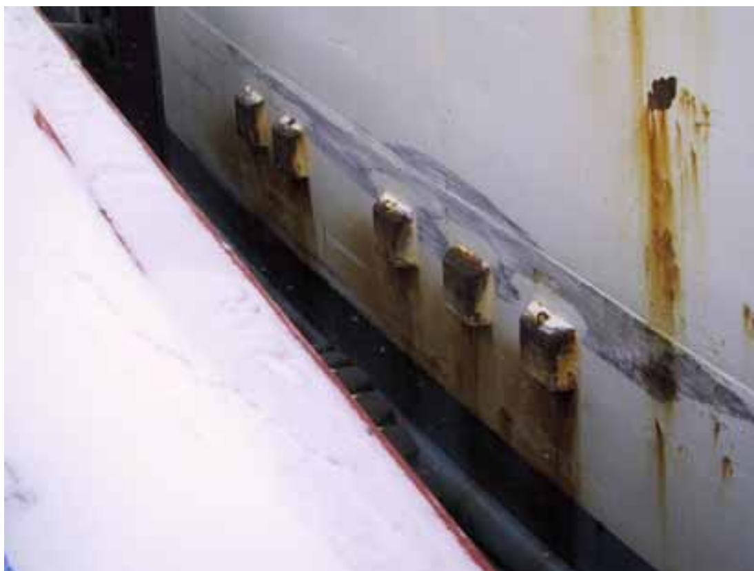
Bild 10. Skyddshattarna på luftrören till barlasttankar.
