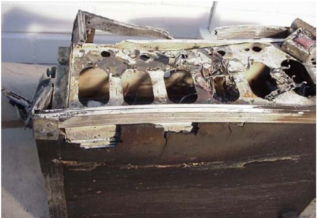
Bild 7. På dimmerns andra långsida har det funnits sex dubbelvägguttag, i vilka scenbelysningsbatterierna var inkopplade. Dimmerns kontrollelektronik var datastyrd.
