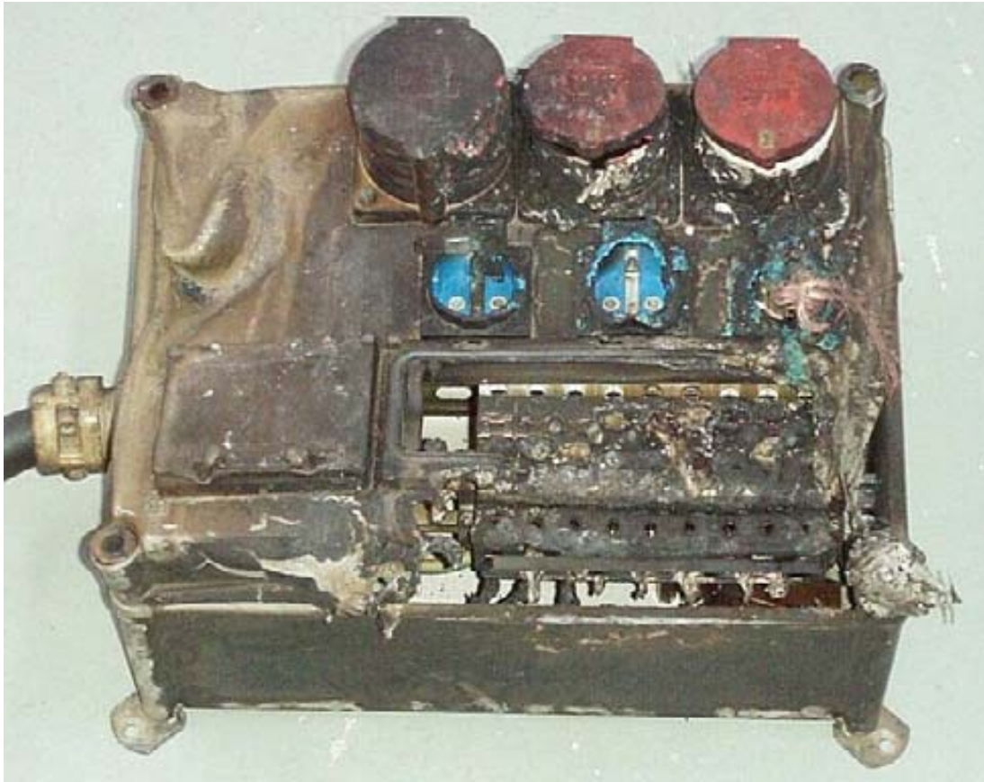
Bild 3. Uttagscentralen med ledningsskydds brytare.
