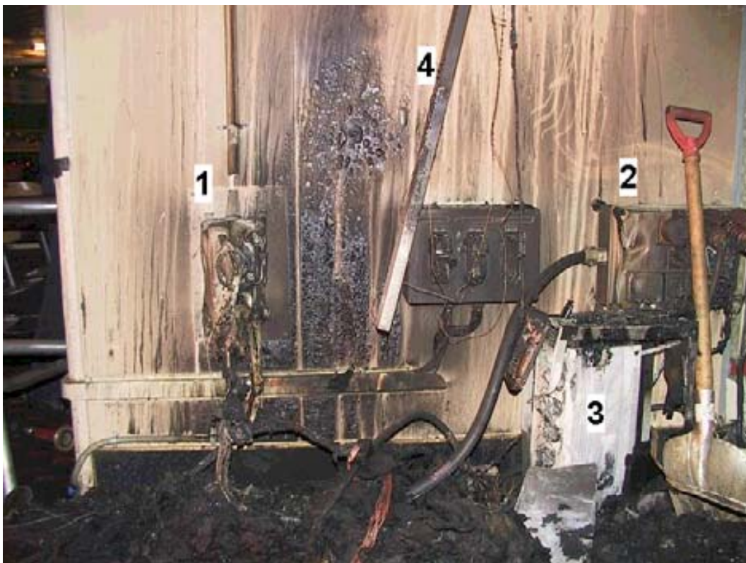
Bild 2. Väggen med utrustning bakom den brända estradridån inkl. Utrustningen. 1.) 3-fasuttag, 2.) stickuttagscentral, 3.)ljusregulator, s.k. "ljusorgel", 4.) ridåns nedböjda ridåstång av aluminium.
