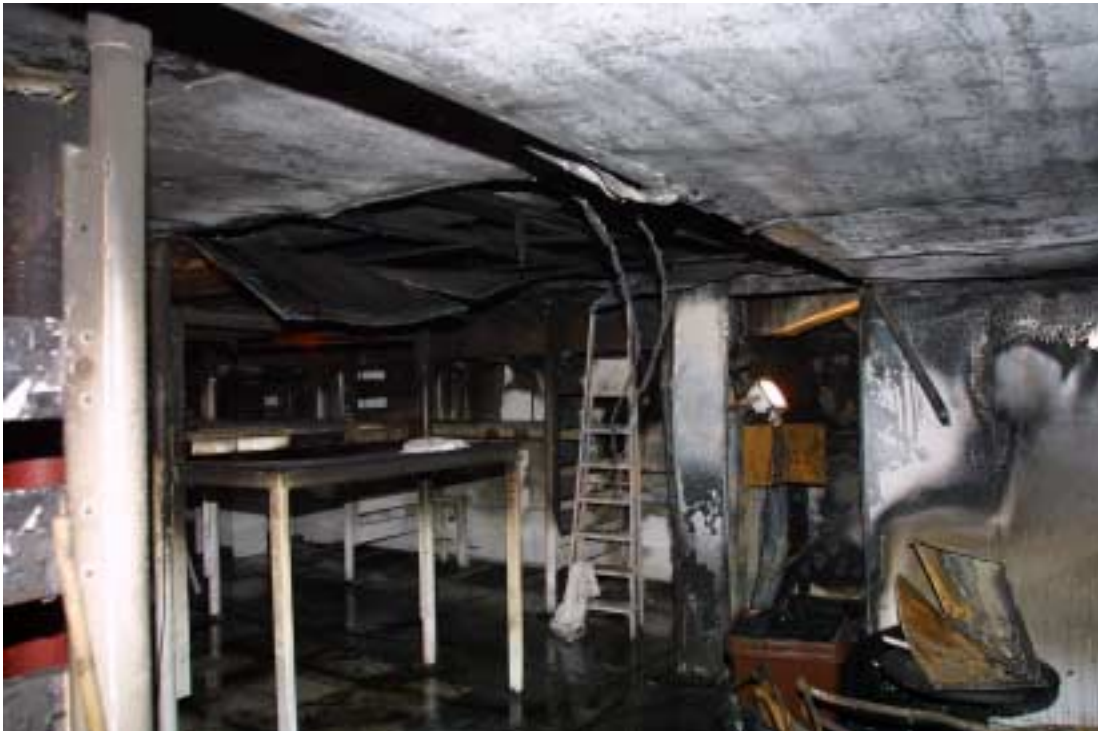
Bild 8. Tax-free-lagret. Dörröppning för centraldammsugarrummet är till höger.
