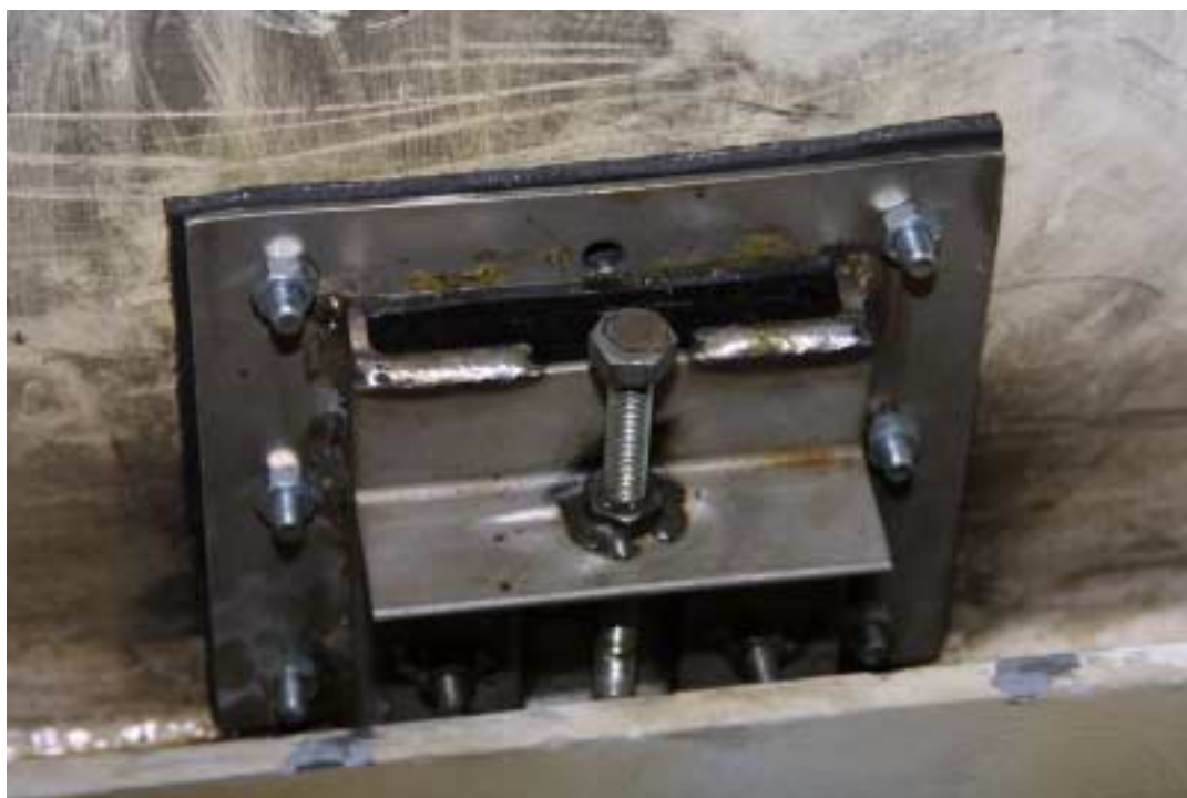
Bild 5. Vattentät skiva på sidan av torrtanken.
