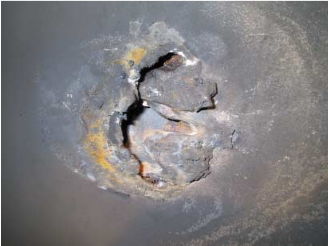
Bild 7. Närbild av hålet på centraldammsugarrummets tak.
