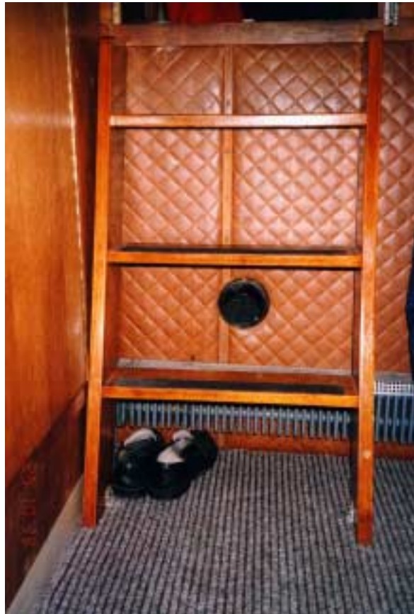
Bild 15 Genomföringen för värmeaggregatet i skottet mellan försalongen och maskinrummet..
