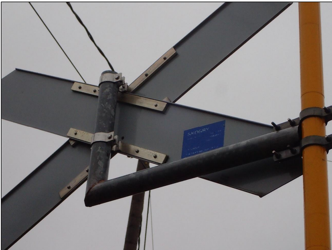
Bild 6. Vid plankorsningar utan varningsanordningar anges bankilometer med en liten dekal bakom trafikmärket för plankorsning. I plankorsningen där olyckan inträffade hade dekalen bleknat. (Bild: OTKES)
