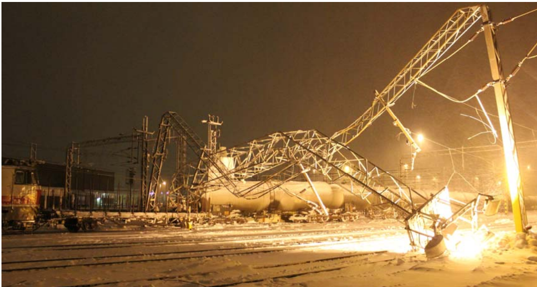
Kuva 2. Kuvan keskellä oleva säiliövaunu törmäsi suistuttuaan valomastoon, joka kaatui sähkörataportaalin päälle.
