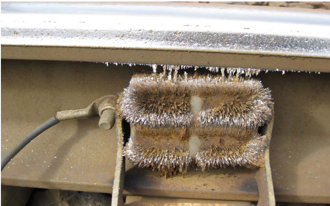
Kuva 16. Eristysjatkoon sijoitetut magneetit keräävät tehokkaasti kiskosta ja pyöristä irtoavaa metallilastua.
