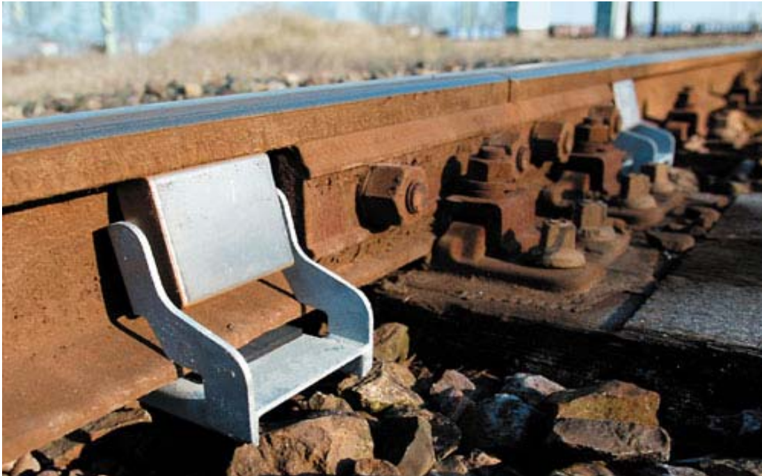
Kuva 15 Kuvassa kiskon eristysjatkoon asennetut magneetit.
