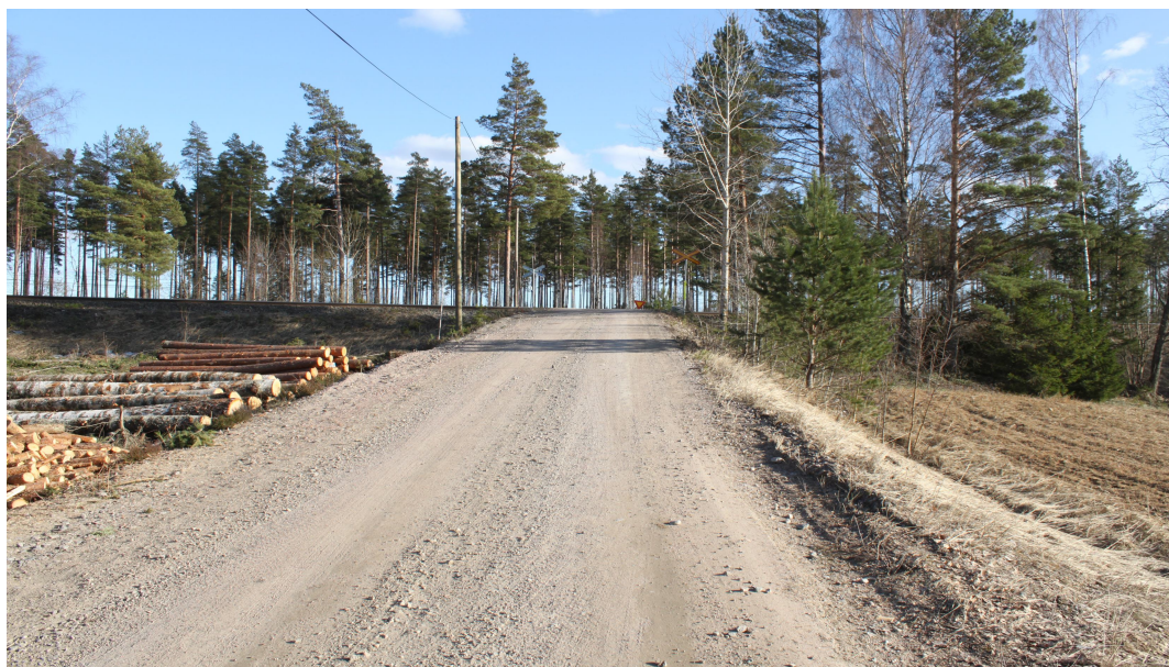
Kuva 5. Näkymä kohti tasoristeystä henkilöauton tulosuunnasta noin 30 metriä ennen tasoristeystä
