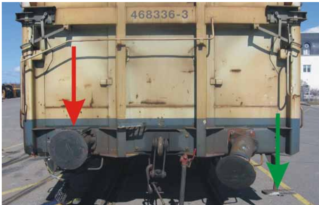
Kuva 2. Vaunun päädyn vauriot. Vaihtotyönjohtaja seisoi puskimen päällä olevalla astimella (punainen nuoli) ja junamies kulma-astimella (vihreä nuoli).
