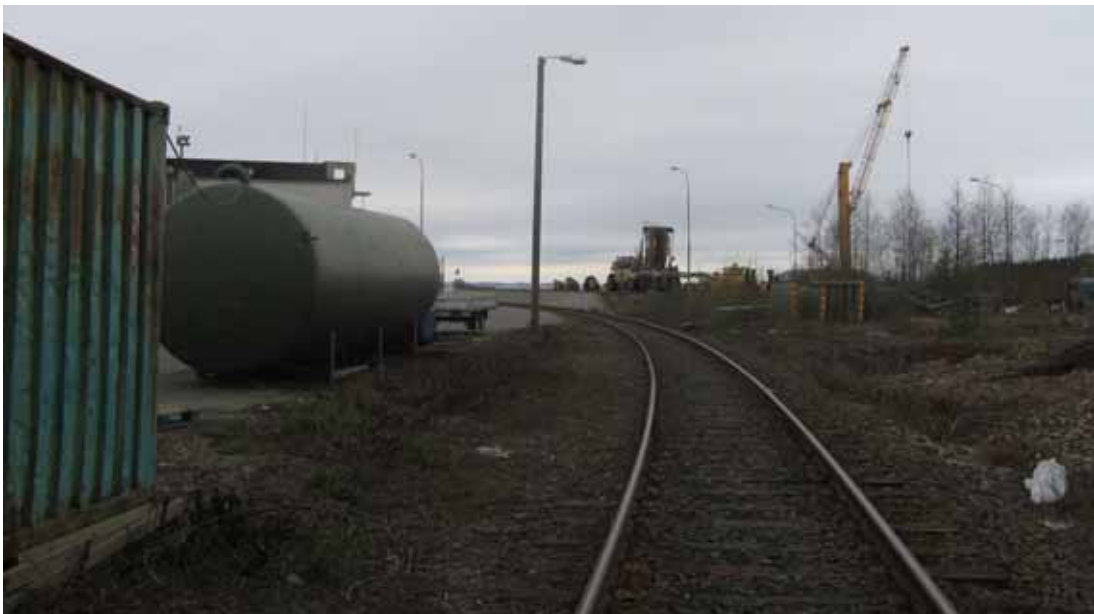
Kuva 6. Raiteen oikealla puolella oleva lastauslaituri.
