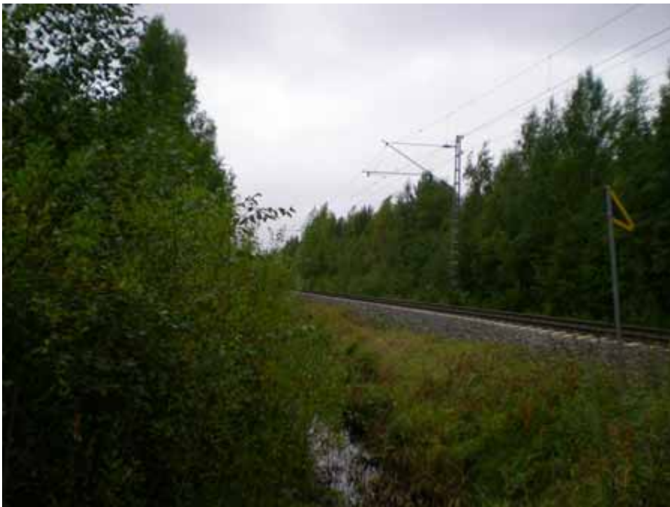
Kuva 4. Näkemä 8 metriä ennen kiskoja ratatyöyksikön tulosuuntaan. Pensaskasvillisuus häikäsi näkyvyyttä.
