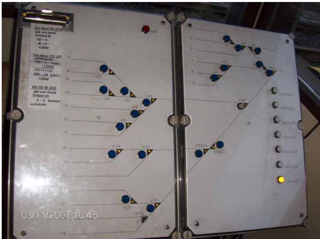
Kuva 4. Vaihdekojussa oleva ohjaustaulu. Vaihteita käännetään sinisillä painonapeilla. Vaihteen ilmaisimena on valkoinen valo vaihdekuviossa.
