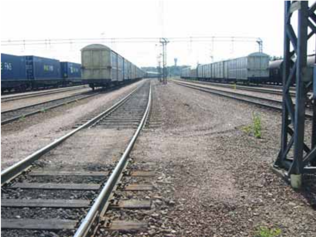
Kuva 5. Näkymä vasten vaihtotyöyksikön kulkusuuntaa. Junamies jäi makaamaan kiskon viereen kuvassa näkyvän hiekkatasokäytävän jälkeen. Kuvassa raiteen vasemmalla (vaihtotyöyksikön kulkusuunnassa oikealla) puolella on kävelykulkutie, mutta oikealla puolella on tavallista raidesepeliä.
