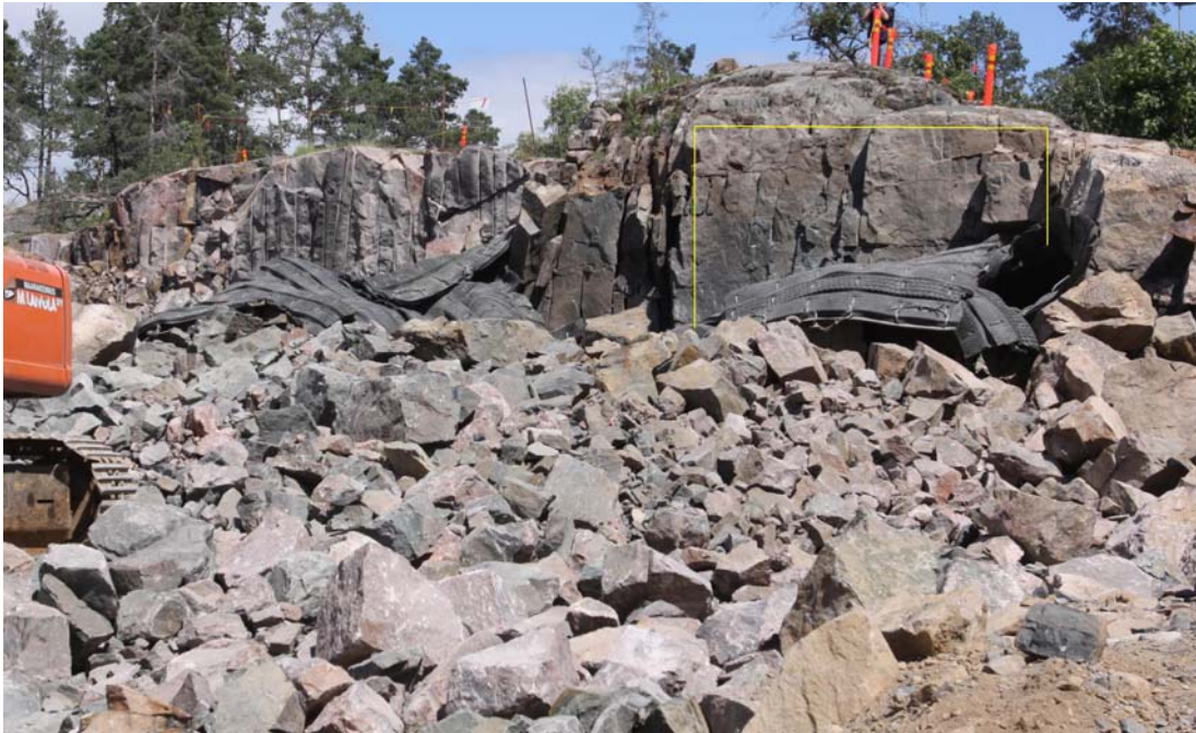
Kuva 4. Onnettomuuspaikka kivien heittosuunnasta lännestä. Kentän sijainti on merkitty keltaisella. Kallion rikkonaisuus on nähtävissä. (Kuva: poliisi.)
