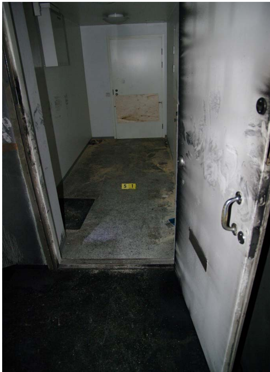
Kuva 15. Viidennen kerroksen kolmen huoneiston yhdyskäytävä.
