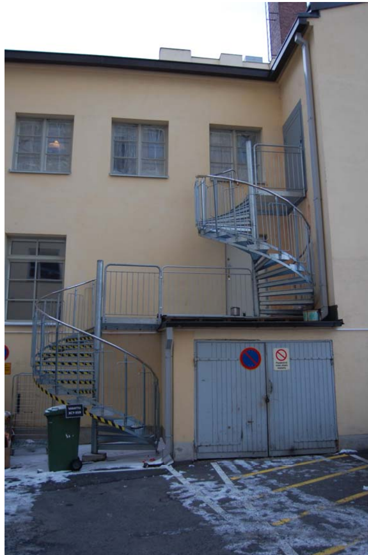
Kuva 8. Sisäpihan kierreporras (yökerhon poistumistie).
