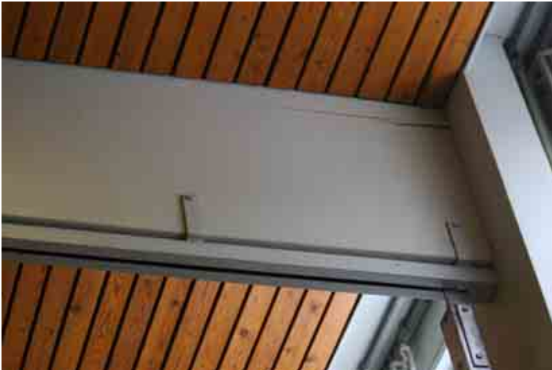
Kuva 8. Halkeama palkin yläreunassa ja alhaalla oikealla rekkitelineen pystytanko.
