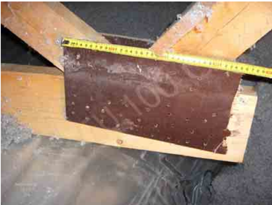
Kuva 2. Murtunut liitoslevy.
