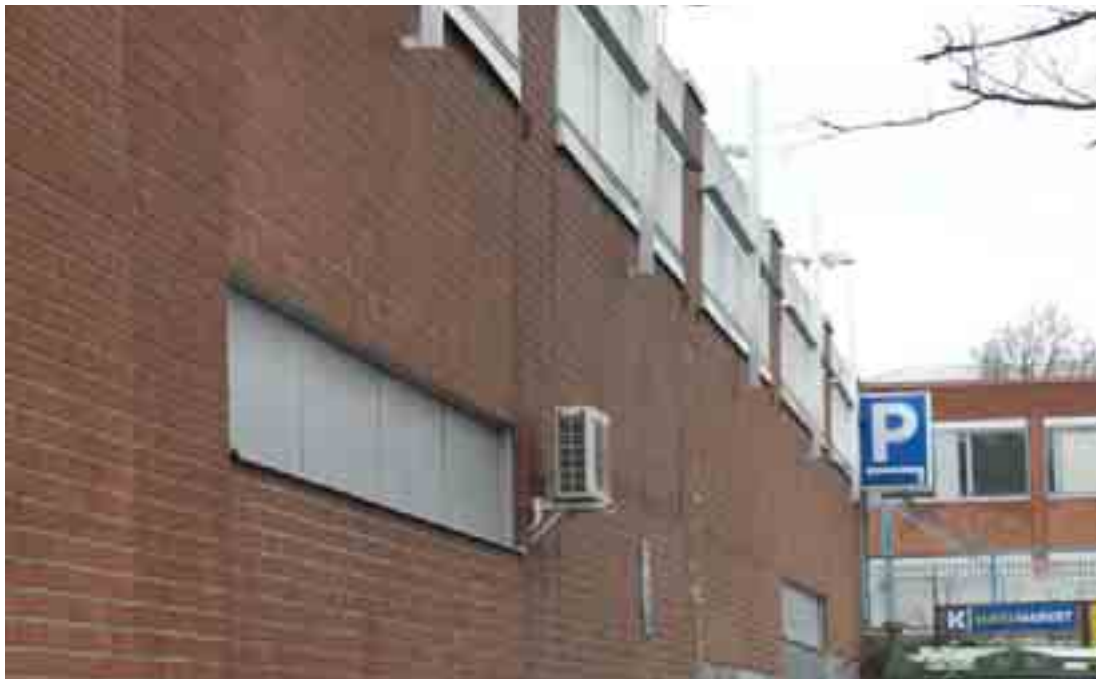
Kuva 10. Julkisivuelementtejä, jotka olivat silminnähden ulospäin kallellaan
