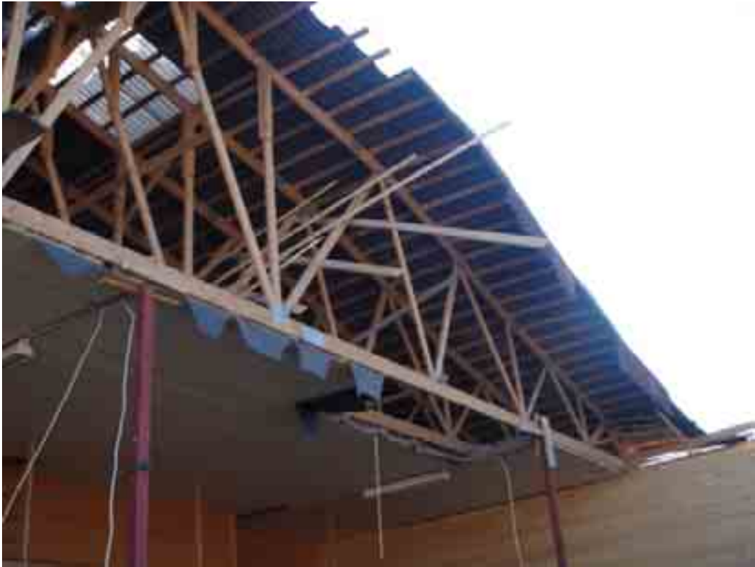
Kuva 24. Ylös jäänyt 22 metrin pituinen naulalevyristikko.
