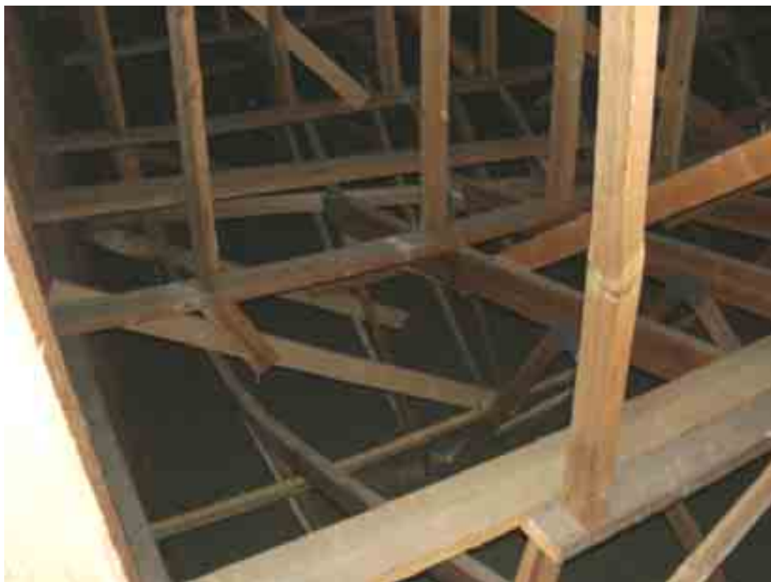
Kuva 17. Palokunnan ennen romahdusta ottama kuva yläpohjasta. Kuvassa yläpaarteita, joista yksi on taipunut ja kaksi katkennut jatkoksen kohdalta.
