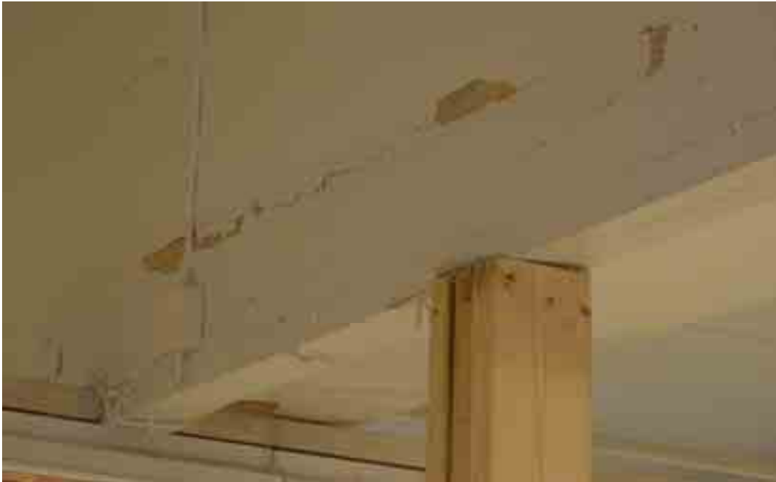
Kuva 13. Murtumisen eteneminen palkissa. Tukipilari palkin alle on asennettu vaurion havaitsemisen jälkeen.
