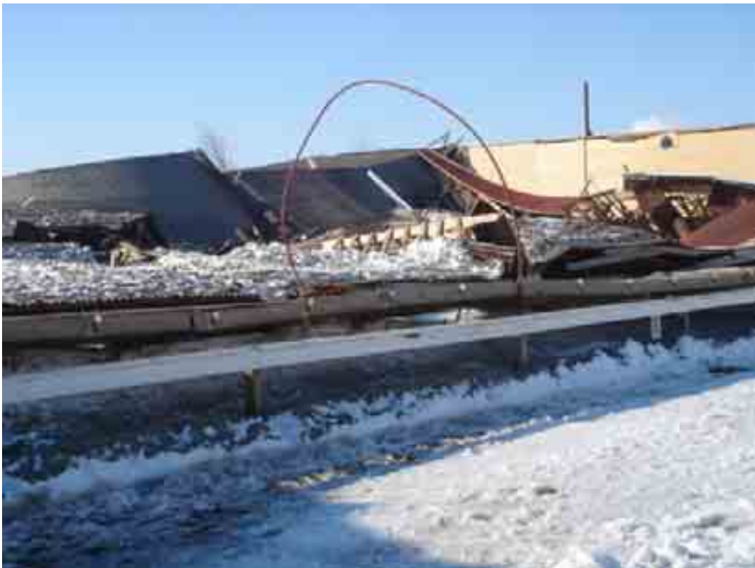
Kuva 23. Maneesin kattoa romahti 1 100 m 2 alueelta.
