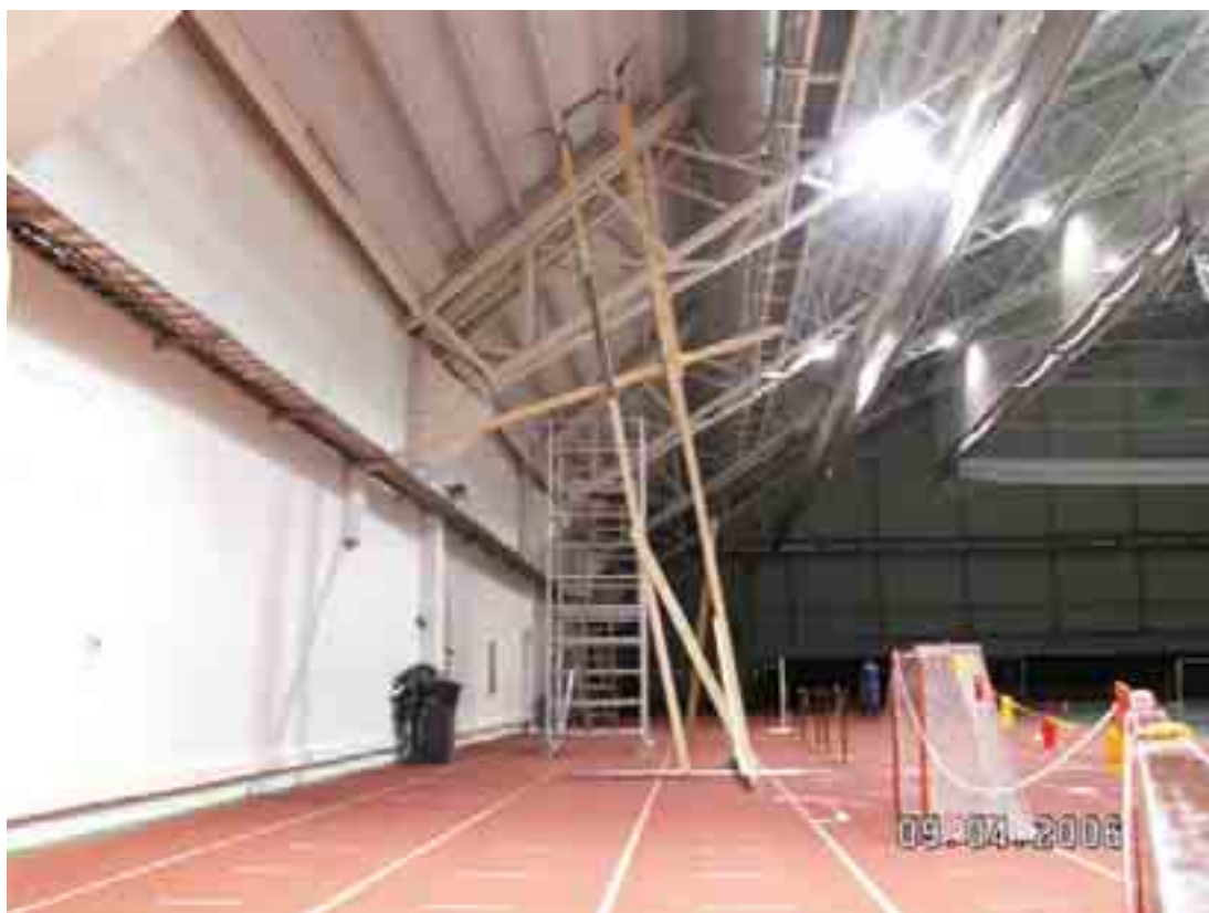
Kuva 20. Hallin katon tuenta vauriokohdassa, jossa vesikaton poimulevyt irtosivat toisistaan niiden saumakohdassa.
