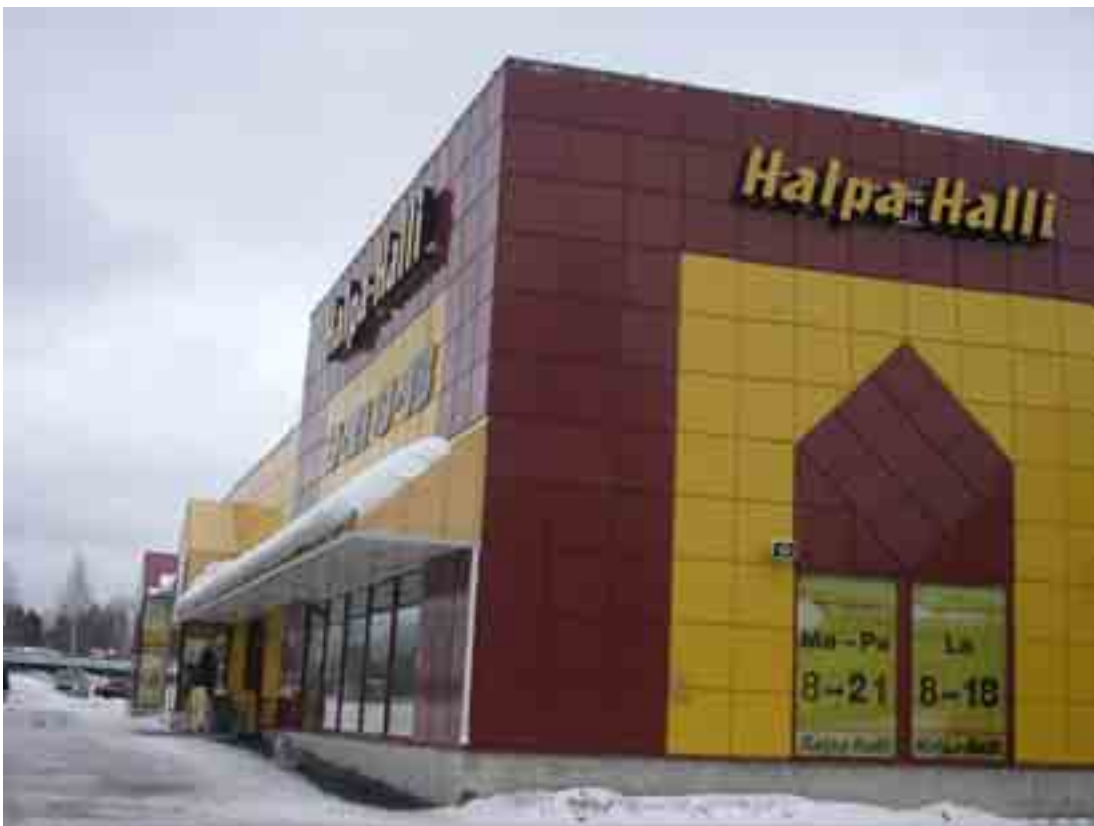
Kuva 14. Pelastuslaitoksen vauriokohdasta ennen romahdusta ottama kuva.
