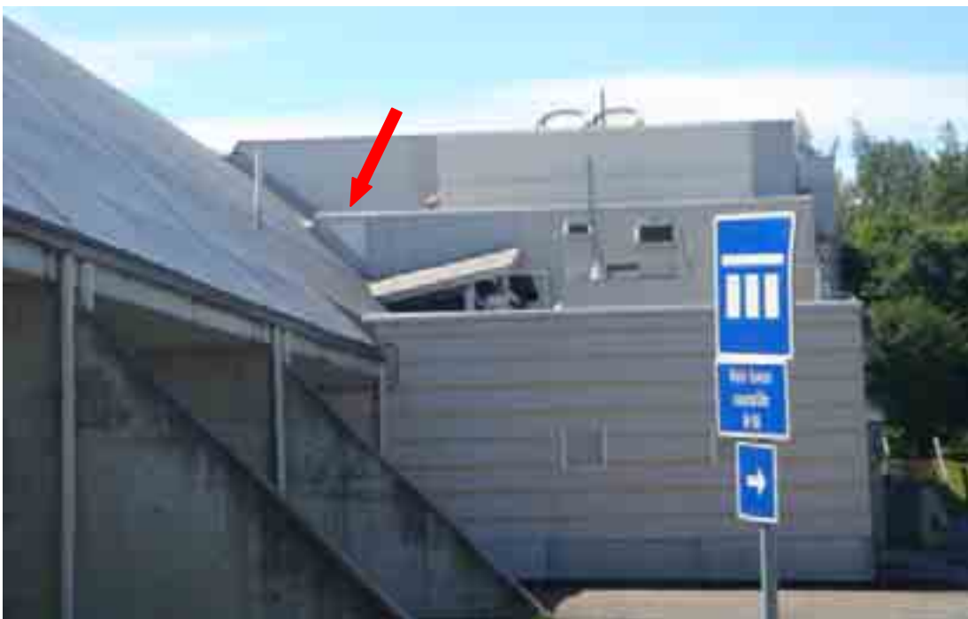
Kuva 19. Lumen ja jään valumisesta aiheutuneen vaurion sijainti on siipirakennuksen toiseksi ylimmällä kattotasolla seinämän takana noin metrin korkeammalla kuin katosta ylös pistävä ilmastointiputki.
