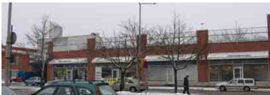
Kuva 9. Yleiskuva rakennuksesta. Rakennuksen yläosassa näkyy pysäköintitasolla olevia autoja ja julkisivun korotusosia.
