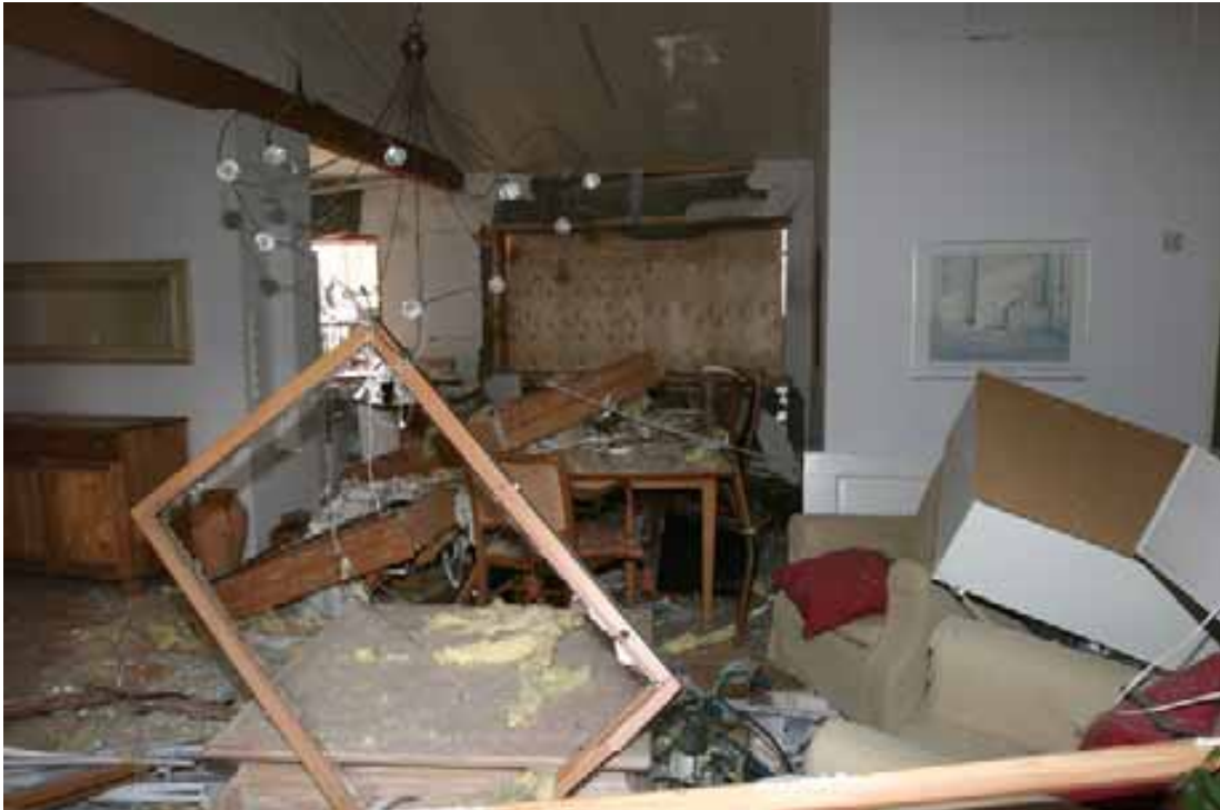
Kuva 5. Vaurioita lähimpänä räjähdyspistettä olleen paritalon olohuoneessa (kuva: Länsi-Uudenmaan tekninen rikostutkimuskeskus).
