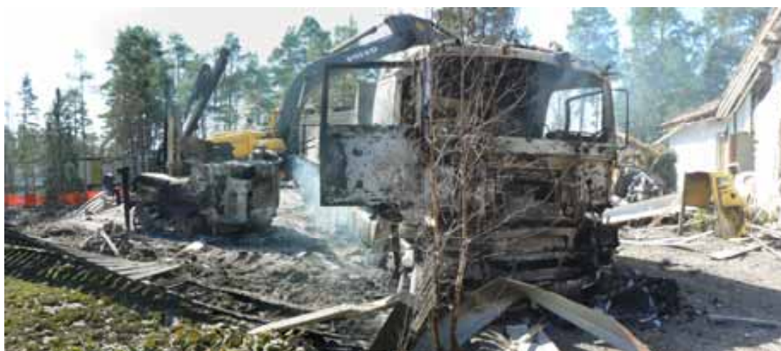
Kuva 1. Nuolirinne 3:n työmaa räjähdyn jälkeen. Etualalla louheenkuljetusajoneuvo, vasemmalla poravaunu ja kuvassa oikealla lähimpänä ollut paritalo.
