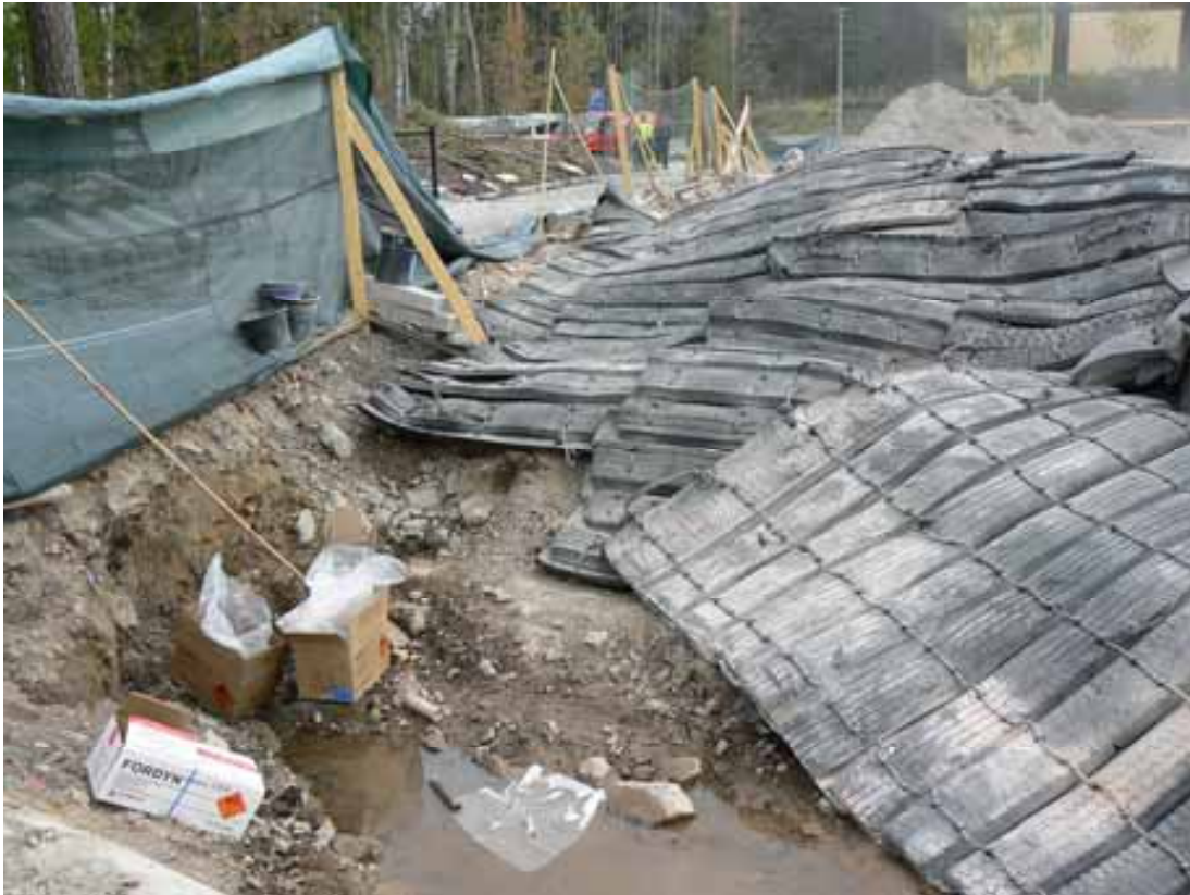
Kuva 9. Räjähteiden säilytystä koulun vieressä muutaman metrin päässä kävelytiestä, jossa ihmisiä liikkuu.
