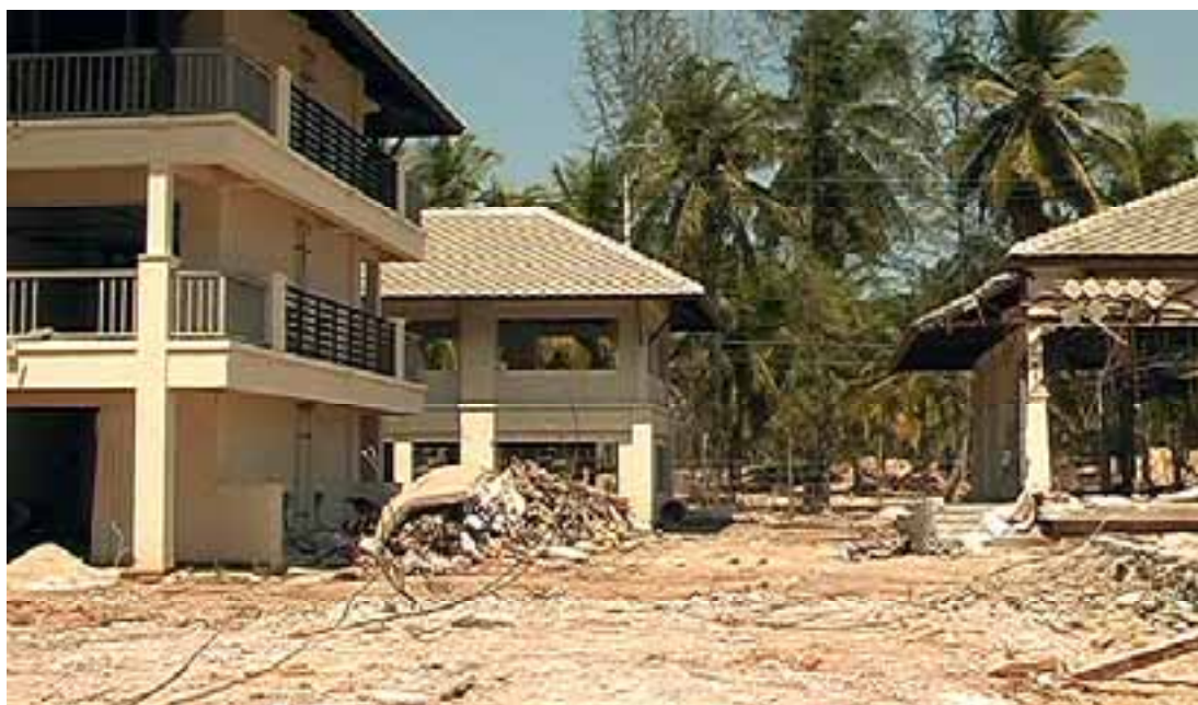
Bild 17. Stabilt byggda hus klarade sig utan att falla samman, i synnerhet om de hade icke bärande väggar av lätt konstruktion och fönster, som rasade på grund av vattentrycket. De översta våningarna i trevåningshusen bevarades intakta.
