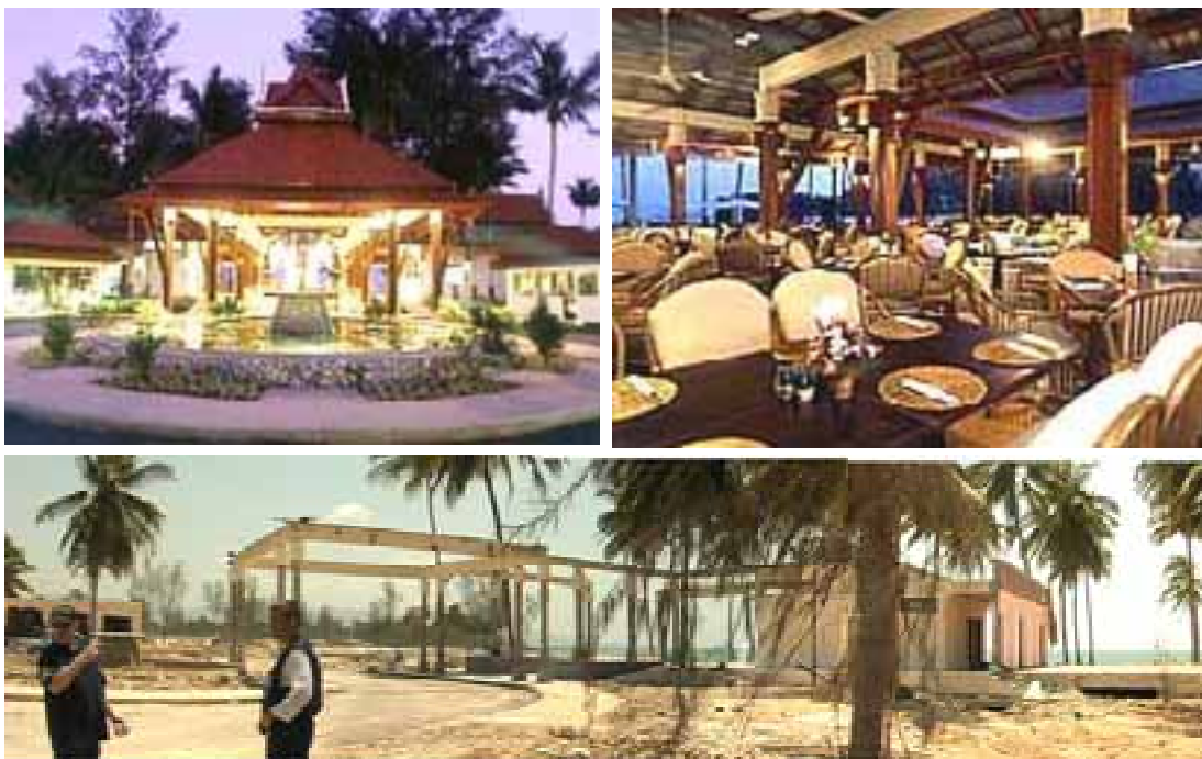
Bild 16. Receptionen i hotellet Blue Village Pakarang Resort före och efter tsunamin. På satellitbilder kan man se att taket ovanför trafikrondellen har funnits kvar ännu sedan tsunamin dragit sig bort. Vattenhöjden ovanför marken var omkring 5 meter.
