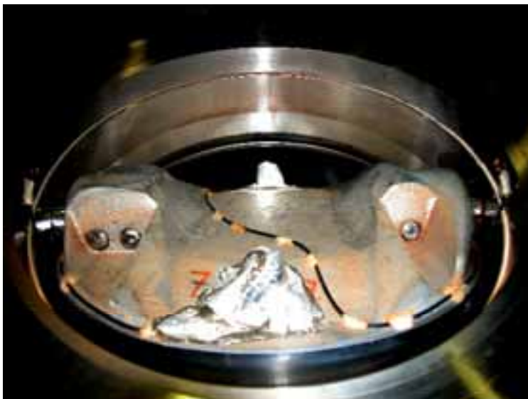
Kuva 26. Venttiili oli näkyvästi likaantunut puhalluskokeessa. Vaaleanruskean pölyliian jakauma selventää jossain määrin kaasun virtausta raottuvan läpän ohi hitaamman virtauksen alueille sekä läpän taakse.
