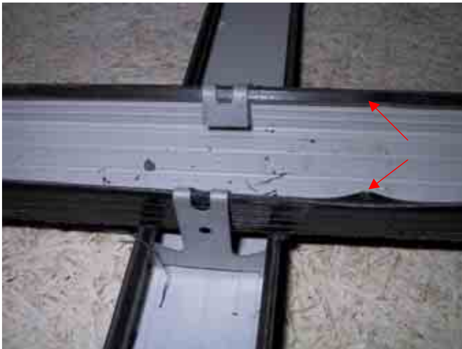
Kuva 4. Kylpylän alakaton romahtaminen Kuopiossa 4.9.2003. Jousiripustin on irronnut kannatinrangasta ja kannatinrangan kanttaus on pettänyt nuolten osoittamista kohdista. Kuvan keskellä rankojen lukituskappaleet.
