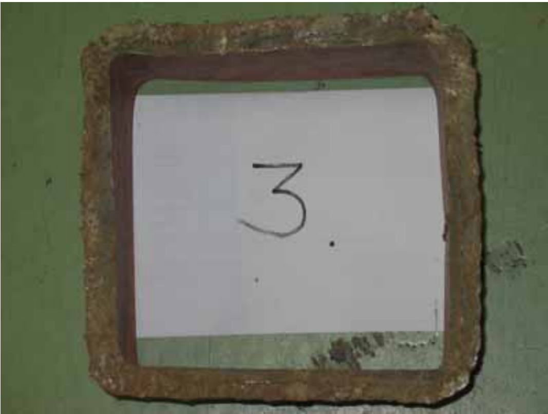
Kuvat 9 ja 10. Pystypalkin 3 murtopinnat.
