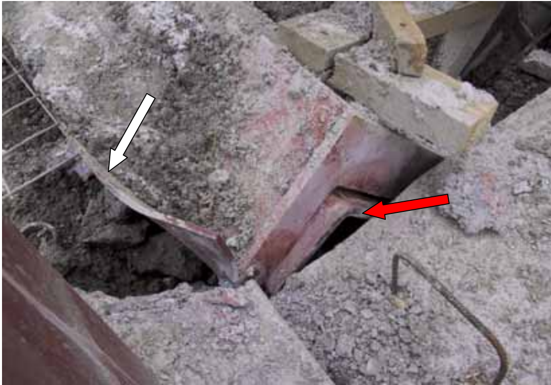
Kuva 7. Onnettomuudessa pudonneen noin kahdeksan metrin pituisen hq-vaakapalkin pää. Palkin suorakaiteen muotoisen poikkileikkauksen korkeus oli 320 mm ja leveys 290 mm. Palkin alapinnan jatkona olivat 135 mm pituiset ulokkeet (valkoinen nuoli), joiden varassa ontelolaatat olivat. Palkin pään sisällä näkyy pilari irronnut konsoli (punainen nuoli).
