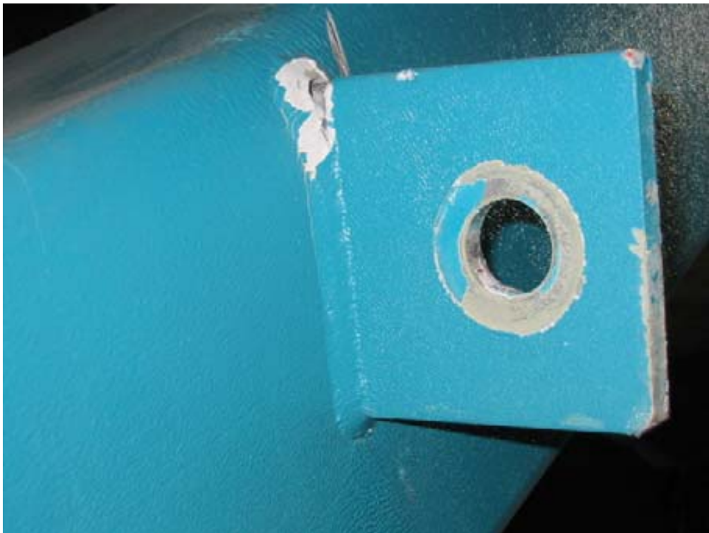
Kuva 12. Orsiristikon alemman korvakkeen vaurio pääkannattajan yläpaarteessa, joka on pullistunut.
