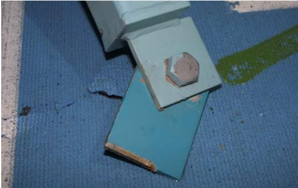
Kuva 11. Orsiristikon kiinnityskorvake, joka on ollut kiinni pääkannattajan lisäkehän yläpaarteessa. Korvake on repeytynyt irti hitsausliitoksestaan.
