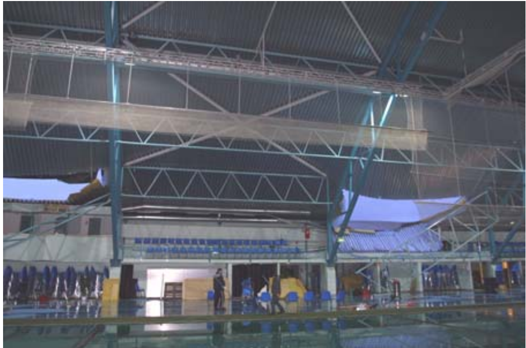
Kuva 9. Vauriokohtat hallin sisäpuolelta kuvattuna. Halliin sisään tullut lumi, eristämateriaalia ja vesikatetta on jo siivottu pois.
