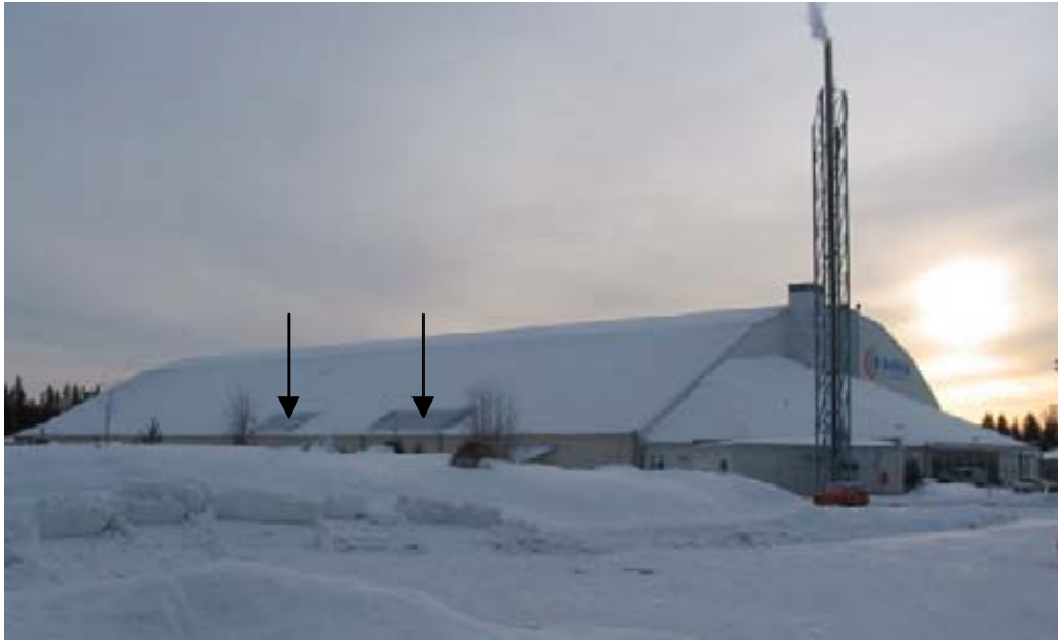
Kuva 2. Halli ulkopuolelta viikon kuluttua kattovauriosta kuvattuna. Katto vaurioitui kahdesta toisistaan erillään olevasta kohdasta. Kyseiset kohdat on jo paikattu ja erottuvat muusta katosta lumettomina kohtina. Kuvassa oikealla hallin länsipääty, jossa on muun muassa pääsisäänkäynti.
