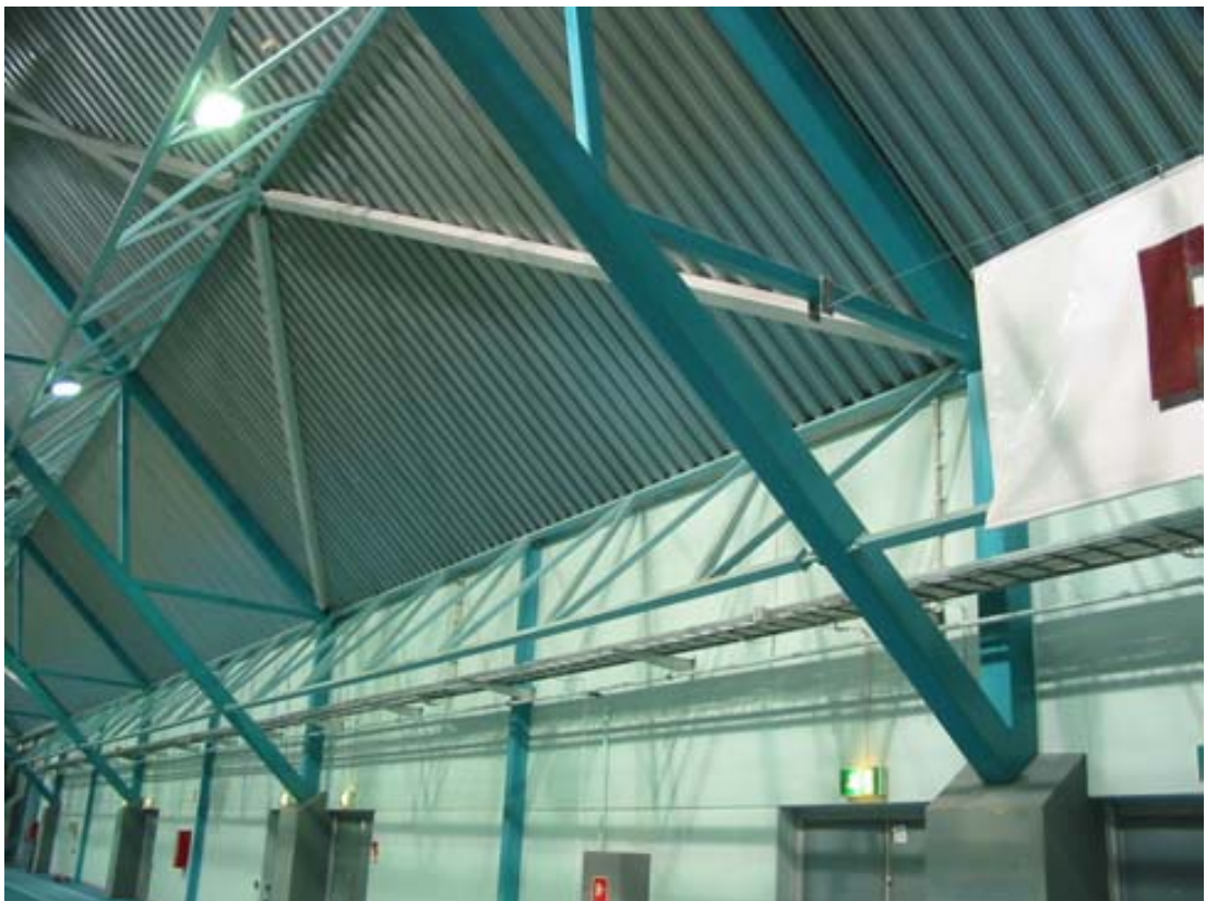
Kuva 17. Poikittaisen jäykistysristikon päätyminen hallin ulkoseinällä linjalla 3. Figure 17. End of transverse bracing lattice in exterior wall of hall, in line 3.
