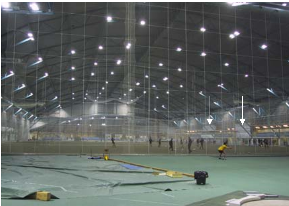
Kuva 3. Halli sisältä. Vauriot tapahtuivat kuvan oikeassa reunassa, valkoisella muovilla peitetyissä kohdissa.
