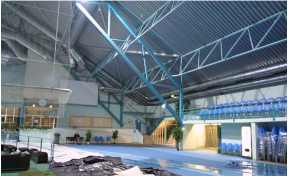
Kuva 16. Poikittaisen jäykistysristikon päätyminen linjoilla A ja 2. Figure 16. Ends of transverse bracing lattice, in lines A and 2.
